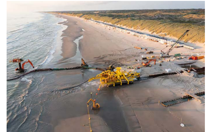
Aanleg kabels Wijk aan Zee.
