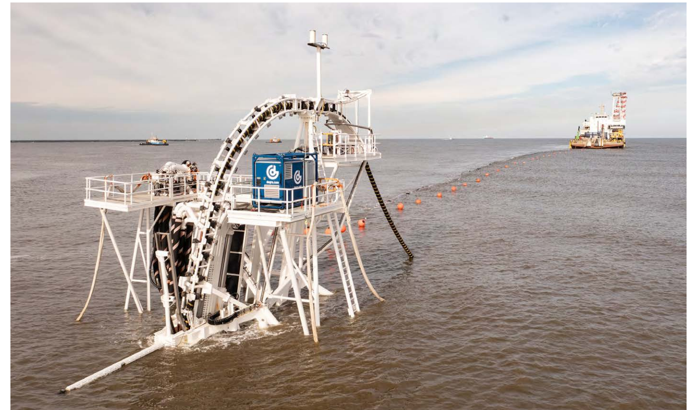
Figuur 8: Aanleggen van een 2 GW elektriciteitskabel op zee.
