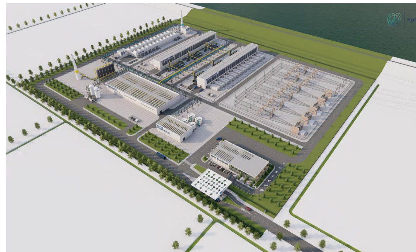
Figuur 4: Impressie van een 1 GW elektrolyser.
