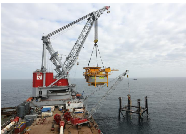
Figuur 2-15: Plaatsing van de bovenbouw op de onderbouw.
