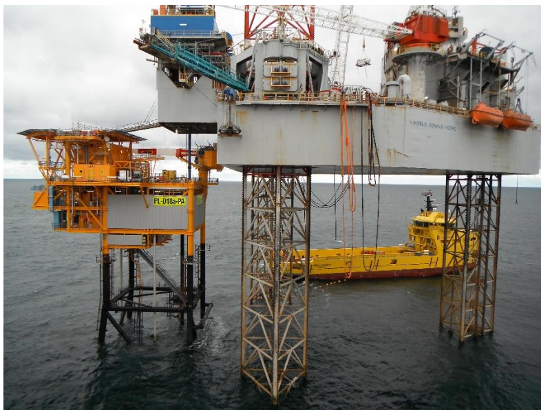
Figuur 2-11: Een drilling rig (op de afbeelding: bij het D18a-A platform).
