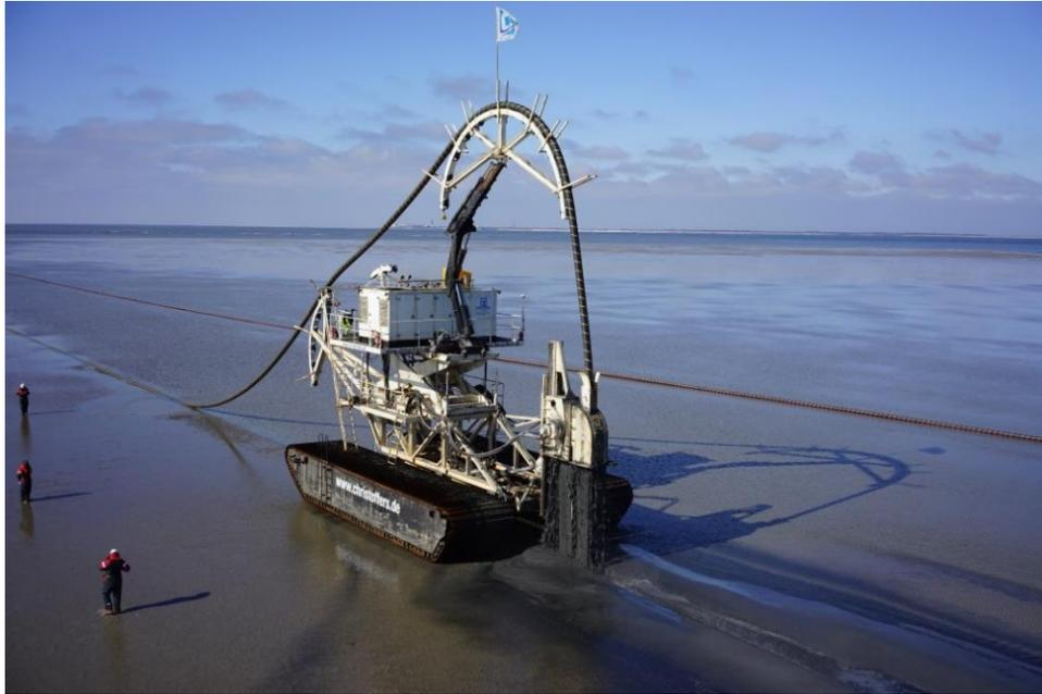
*Ein Beispiel für eine Watt-Grabenfräse – In Zusammenarbeit mit dem NIOZ und Wageningen Marine Research wurde untersucht, wie diese Watt-Grabenfräse eingesetzt werden kann, um die Auswirkungen auf Natur und Ökologie zu minimieren (siehe auch den Teilbericht „Natur“).*
