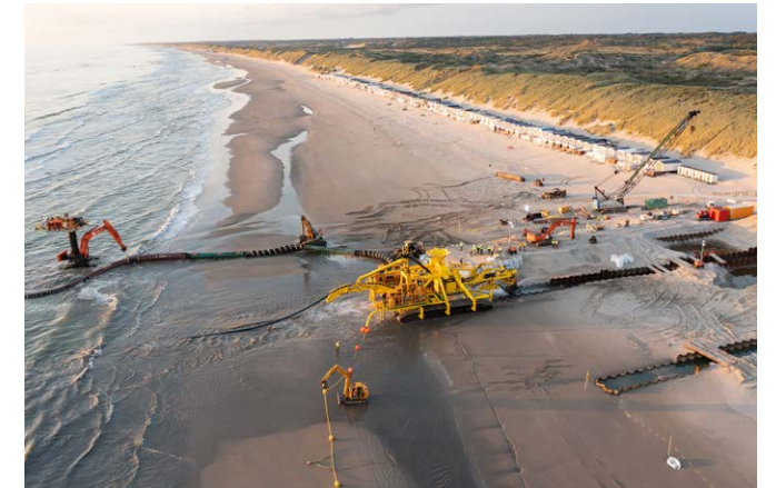
Aanleg kabels Wijk aan Zee.
