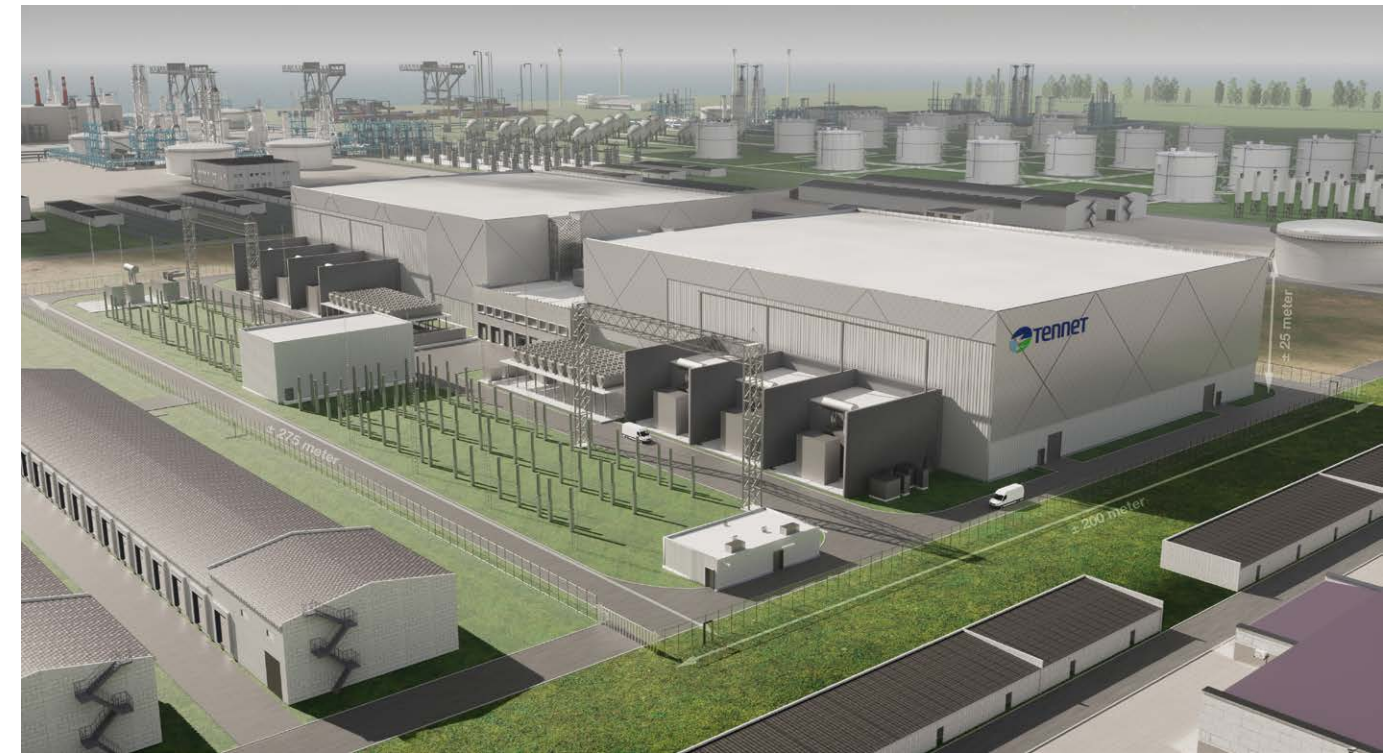
Figuur 1: Impressie van een 2 GW converterstation.
