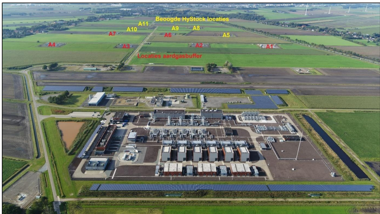
Figuur 2.1 Bestaande en beoogde zoutwinnings-/opslaglocaties aan het maaiveld (zicht in westelijke richting) (bron: MER HyStock)
