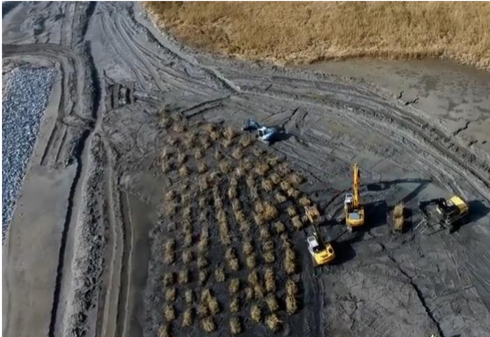
Afbeelding 3.4 Voorbeeld aanbrengen Rietplaggen in project RvR IJsseldelta (print screen uit film met dronebeelden)
