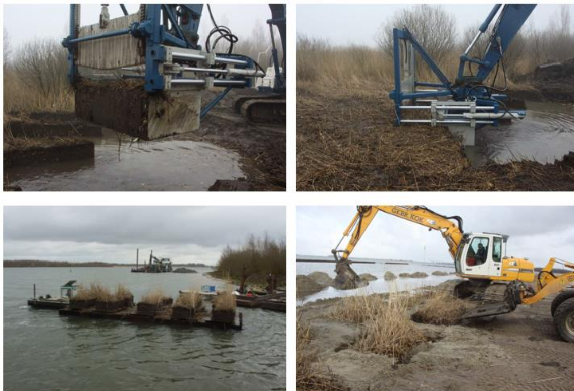
Afbeelding 3.5 Beeldimpressie werkwijze afplaggen en plaatsen rietplaggen (Bron; Scirpus Ecologisch Advies; Evaluatierapport Winning en aanplant van rietplaggen in Ondiepe Zones Ketelmeer en Zwarte Meer)
