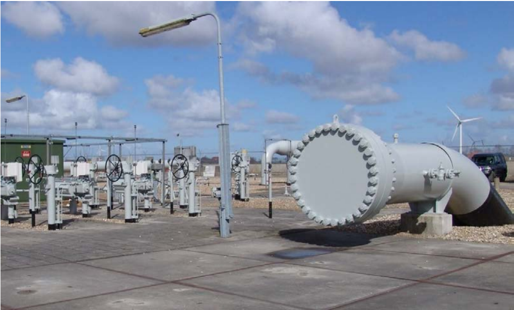
Afbeelding 2.3 Scraper trap (rechts op de foto)
