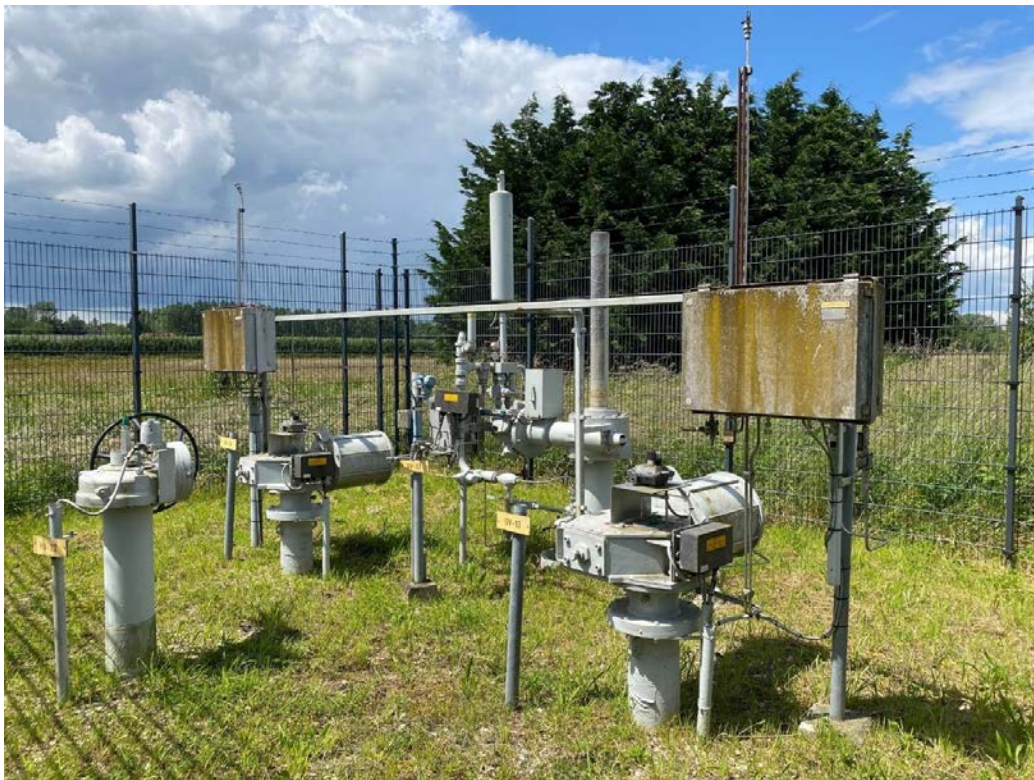
Afbeelding 2.2 Voorbeeld van een afsluiterlocatie
