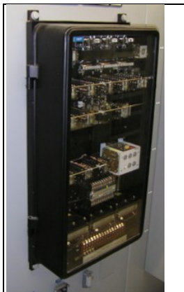
Afb. 6.1: Mechanisch beveiligingsrelais
