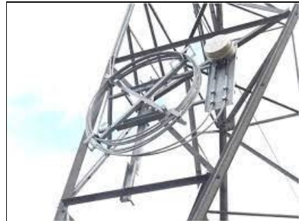
Afb. 3.21: OPGW Koppelkast met extra OPGW-lengte op rol.
