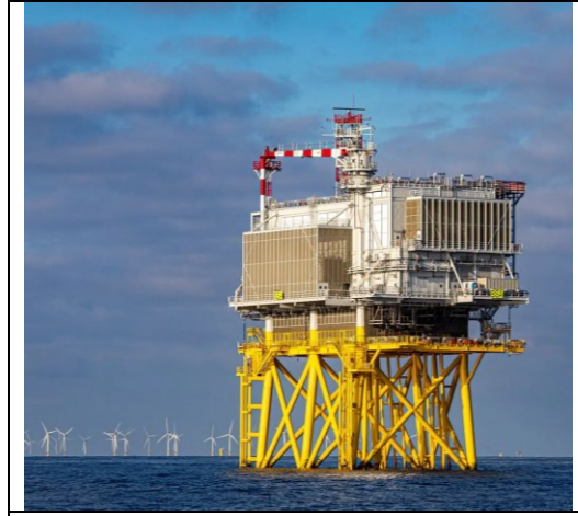
Afb. 1.14: aanzicht van offshore platform.
