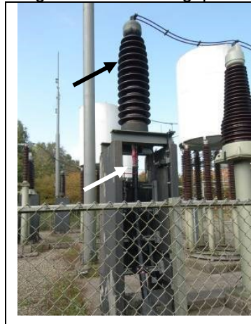
Afb. 2.23: Kabeleindsluiting (zwarte pijl) met kabel (witte pijl)
