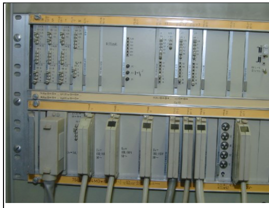
Afb. 6.2: Elektronisch beveiligingsrelais
