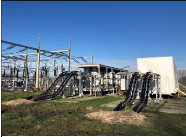
Afb. 1.13: aanzicht van een geplaatste MGU
