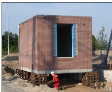
Afb. 1.9: Prefab veldhuisje in aanbouw
