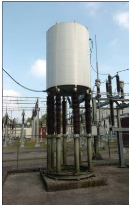
Afb. 2.30: Lucht-gekoelde seriespoel (voor 1 fase) met twee HS-aansluitingen.
