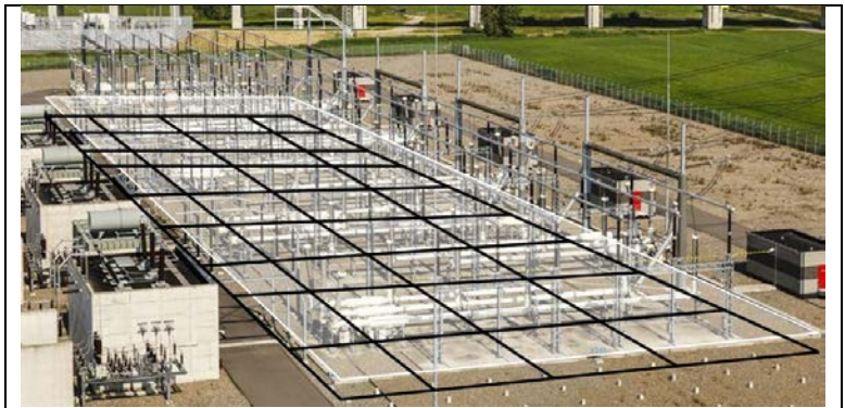
Afb. 2.36: Aardnet op een hoogspanningsstation is als raster (hier schematisch zwart getekend) niet zichtbaar in de grond verwerkt.
