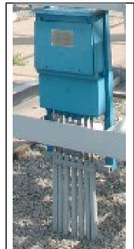
Afb. 5.7: Secundaire aansluitkast
