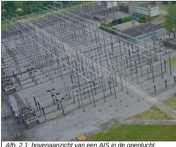
Afb. 2.1: bovenaanzicht van een AIS in de openlucht.
