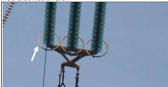
Afb. 3.24: Drievoudige afspanketting met drie coronaringen
