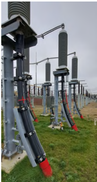
Figuur 3.4.3.3-1 - Voorbeeld bescherming kabel tegen maaien
