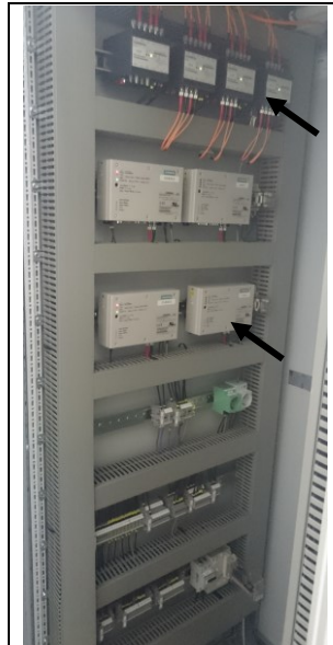
Afb 5.12.: Sterkoppelaars (boven) en optische elektrische omvormers
