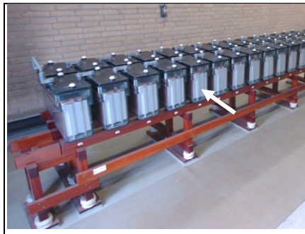
Afb. 5.14: Centrale accu's voor een veilige voeding
