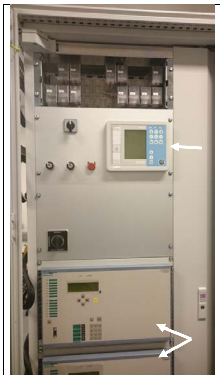
Afb. 6.5: Combikast (beveiliging en besturing) met VBS (boven) en twee differentiaalbeveiligingen (onder).
