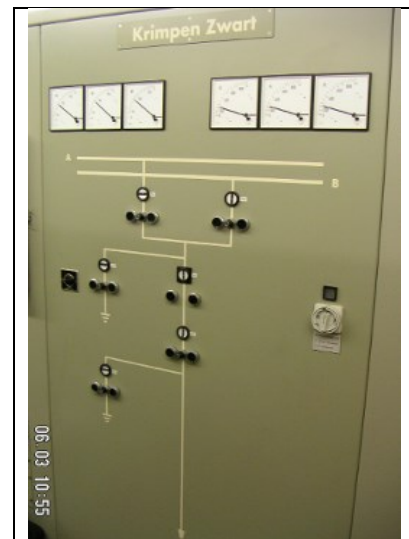
Afb. 5.3: Bedieningsmogelijkheid opgebouwd in een paneel
