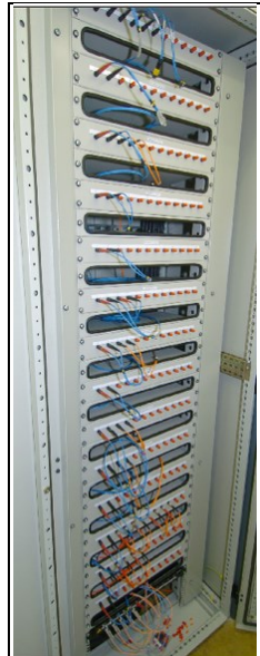
Afb. 5.11: Centraal patchpaneel
