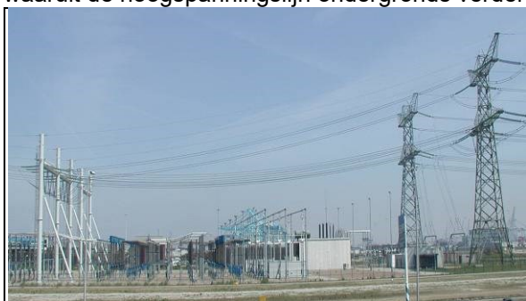
Afb. 3.5: Inlusing via een afspanportaal op een hoogspanningsstation.
