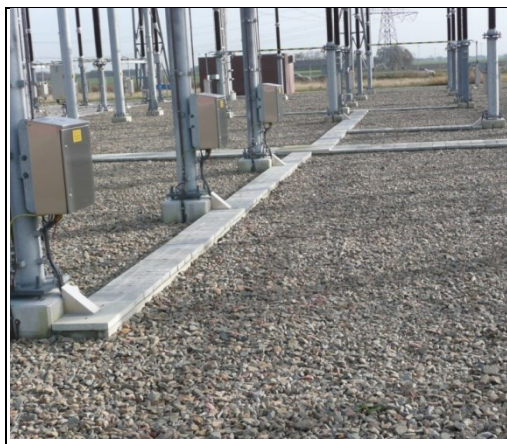
Afb. 1.24: Terreinafwerking met grind
