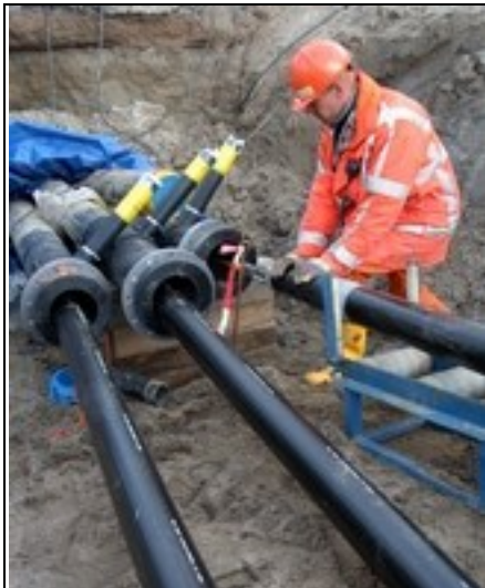
Afb. 4.8: 150 kV kabels die door buizen onder een weg worden getrokken
