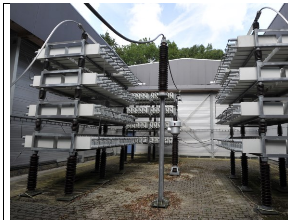
Afb. 2.34: condensatorbank(driefasen)
