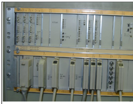
Afb. 6.2: Elektronisch beveiligingsrelais
