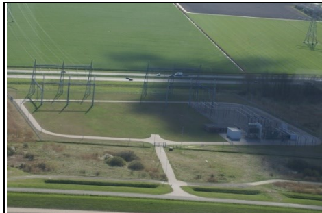
Afb. 1.22: Ringweg om station in aanbouw
