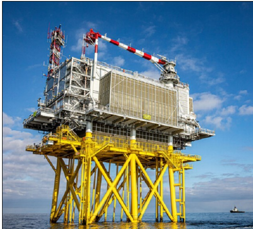
Afb. 2.5: aanzicht van een offshore platform
