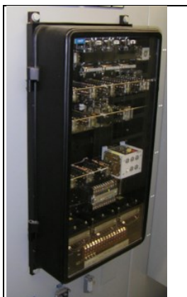
Afb. 6.1: Mechanisch beveiligingsrelais
