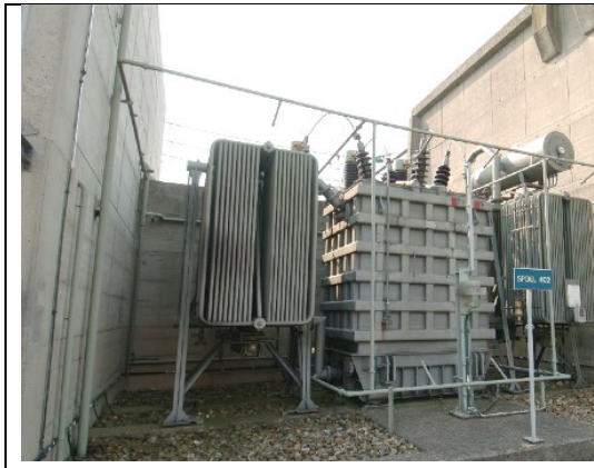
Afb. 2.31: Olie gekoelde seriespoel (driefasen) en zes HS-aansluitingen
