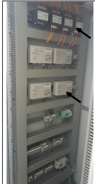
Afb. 5.12.: Sterkoppelaars (boven) en optische elektrische omvormers
