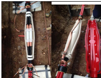
Afb. 4.10: Open 3-fasen kabeljoint met schaaldelen voor 11 kV kabel
