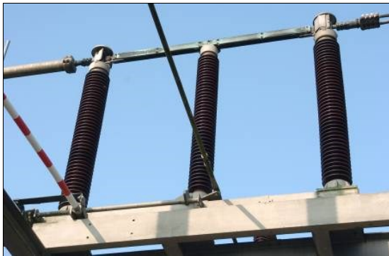
Afb. 2.9: Veldscheider dicht
