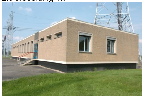
Afb. 1.7: Centraal Diensten Gebouw
