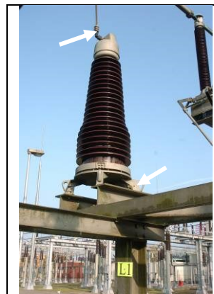
Afb. 2.19: 220 kV spannings- transformator (oud model) met één HS-aansluiting en één aarde-aansluiting.
