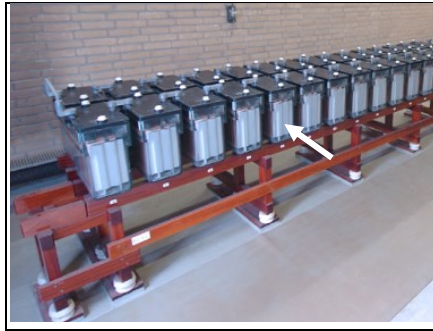
Afb. 5.14: Centrale accu's voor een veilige voeding
