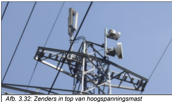
Afb. 3.32: Zenders in top van hoogspanningsmast
