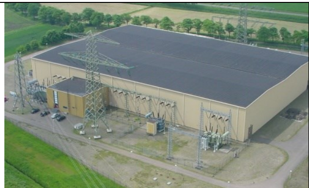
Afb. 1.12: Grote hal waarin zich een hoogspanningsinstallatie bevindt
