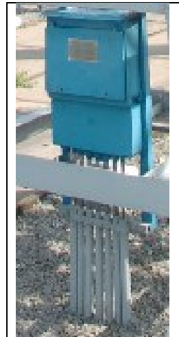
Afb. 5.7: Secundaire aansluitkast
