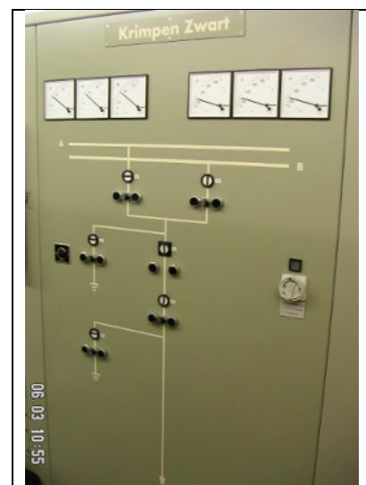
Afb. 5.3: Bedieningsmogelijkheid opgebouwd in een paneel
