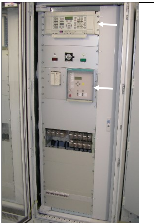
Afb. 6.4: Beveiligingskast met minimum impedantie (boven) en railbeveiliging (midden).
