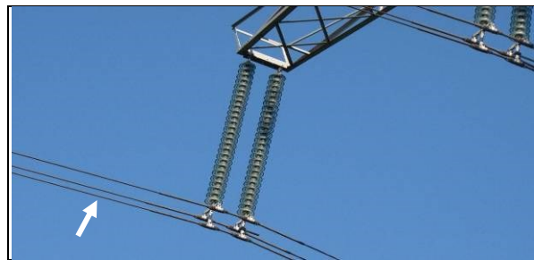
Afb. 3.13: Driebundel fasegeleidersysteem
