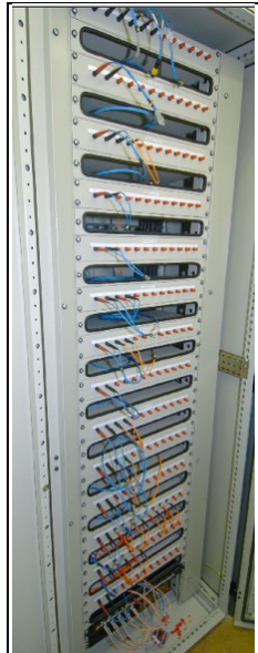
Afb. 5.11: Centraal patchpaneel
