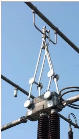
Afb. 2.11: Railscheider (Pantograaf-type) dicht
