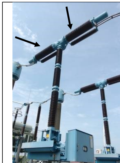
Afb. 2.13: Vermogensschakelaar met twee bluskamers achter elkaar
