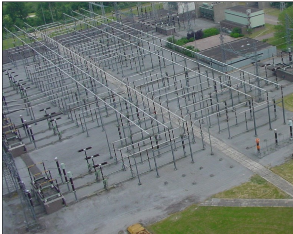
Afb. 2.1: bovenaanzicht van een AIS in de openlucht.
