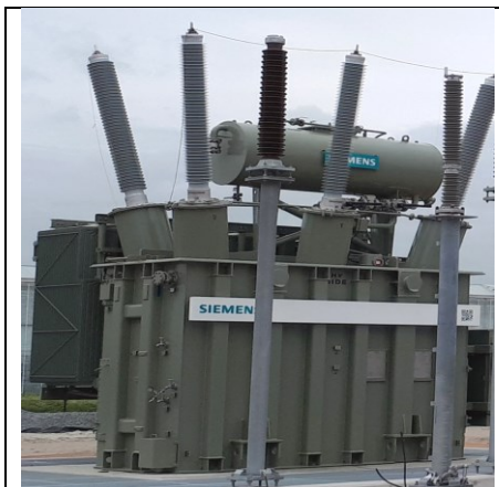
Afb. 2.33: Olie gekoelde compensatiespoel (driefasen) en vier HS-aansluitingen
