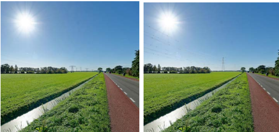
Figuur 5.4 | Visualisatie verandering toekomstige situatie (2x 380 kV, rechts) ten opzichte van huidige situatie (bovengrondse 110 kV-verbinding, links)
