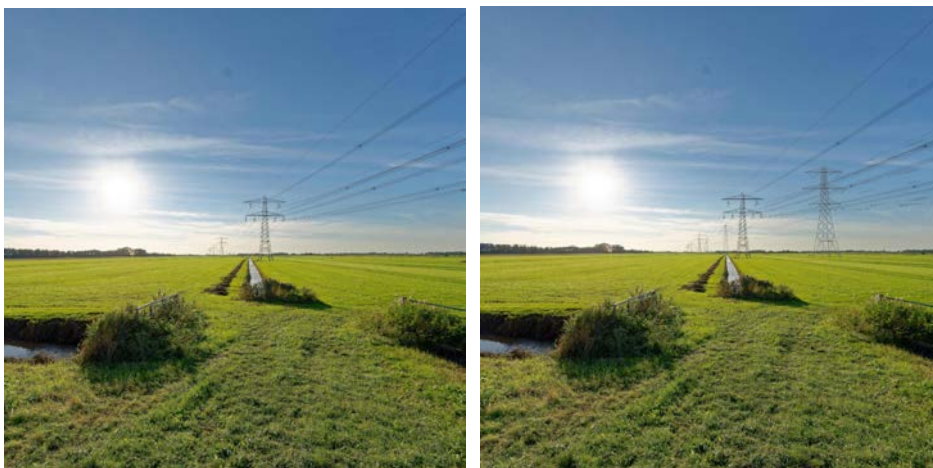
Figuur 5.6 | Visualisatie verandering toekomstige situatie (2x 380 kV naast de bestaande 220 kV-verbinding, rechts) ten opzichte van huidige situatie (bovengrondse 220 kV-verbinding, links)
