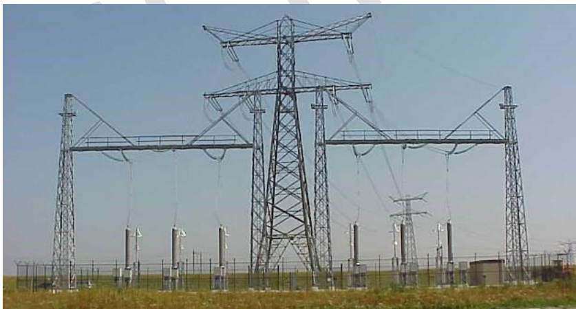
Afbeelding I.7 Kabeleindsluiting (KES)
