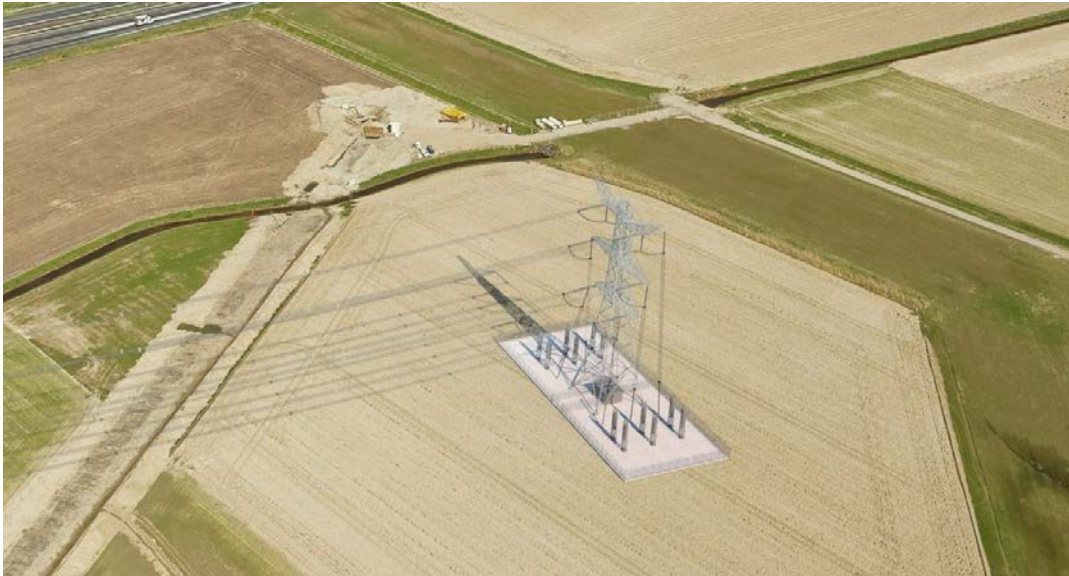
Afbeelding I.3 Opstijgpunt 380 kV-verbinding (foto van de verbinding Rilland-Tilburg)
