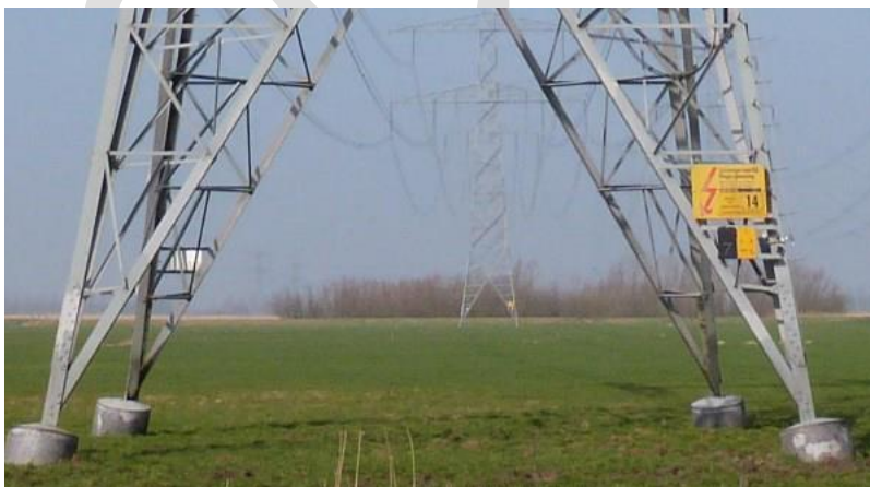
Afbeelding I.4 Fundering van een vakwerkmast
