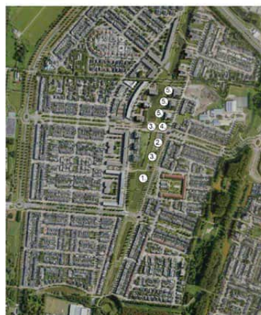
Figuur XX: Een hoogspanningsverbinding in het Gerbrandypark Utrecht
