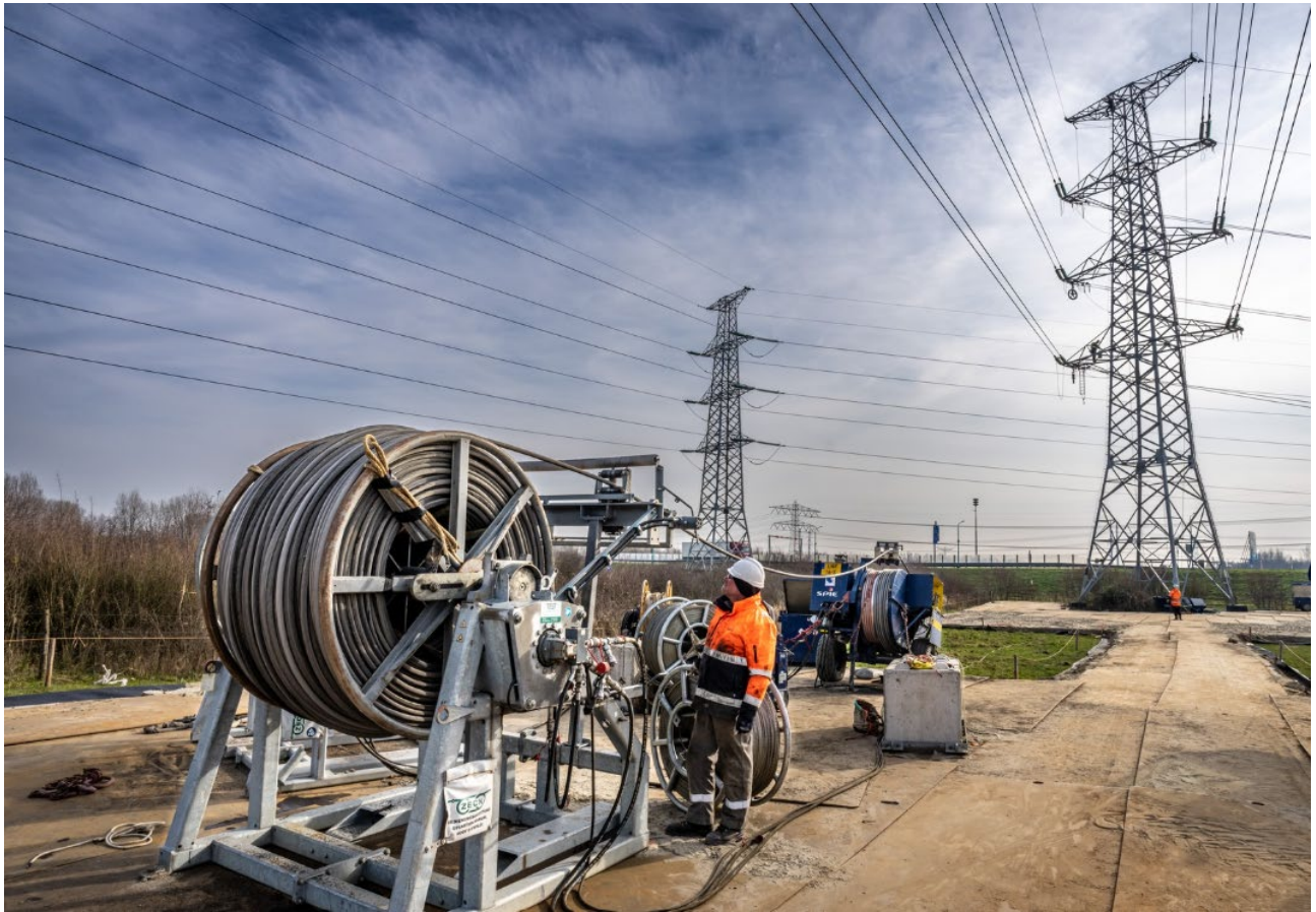
Figuur 5.3: Het intrekken van de geleiders
