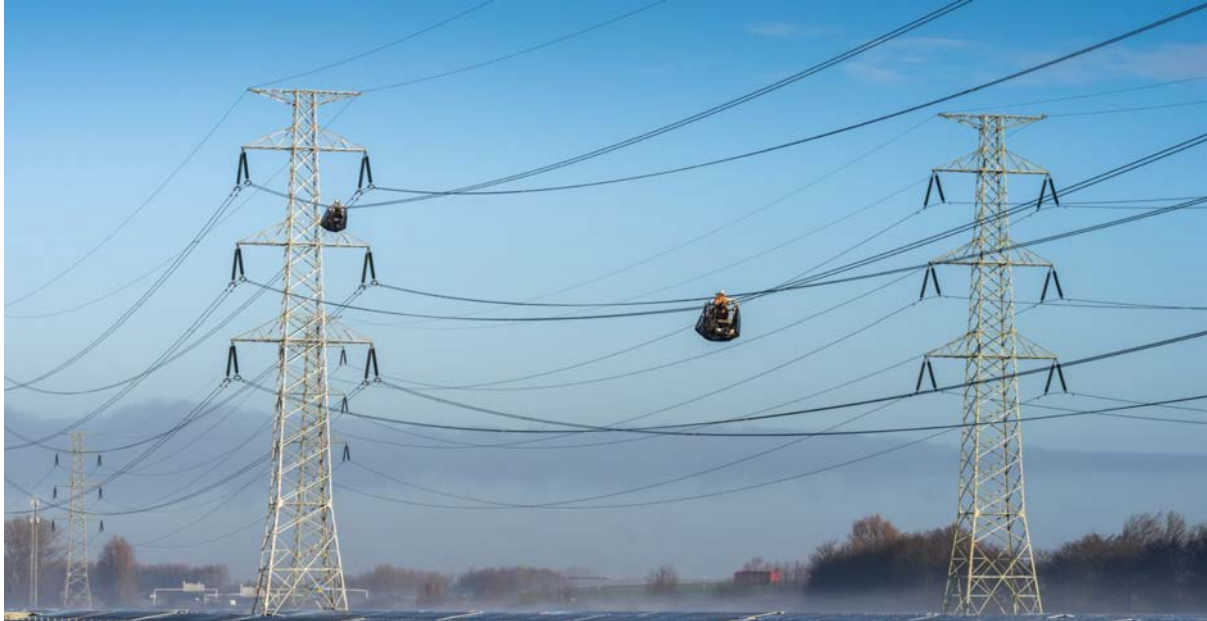
Figuur 5.6: Aanbrengen van bundelafstandhouders met invaarwagens
