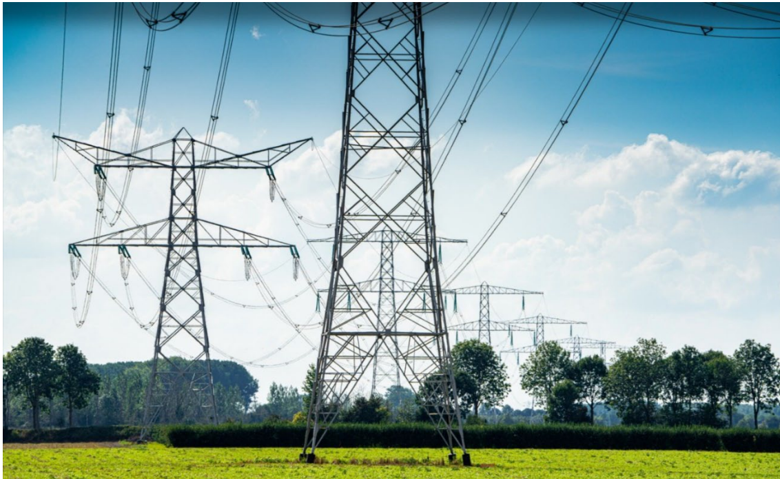
Figuur 5.1: Hoogspanningsverbinding bovengronds (type Donaumasten)
