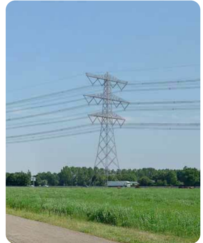
Visualisatie van een vakwerkmast (type Moldau)
