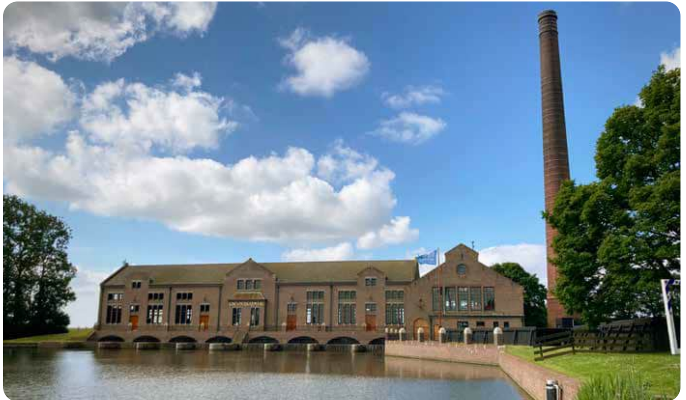
Vooraanzicht van het Ir. D.F. Woudagemaal dat nog steeds in functie is. Opvallend is de 60 meter hoge schoorsteen
