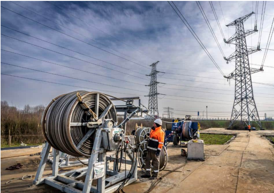
Figuur 3-10 | Intrekken geleiders in hoogspanningsmast
