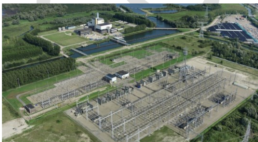
Afbeelding 1.2 380/150 kV-hoogspanningsstation in Diemen (bron: TenneT)
