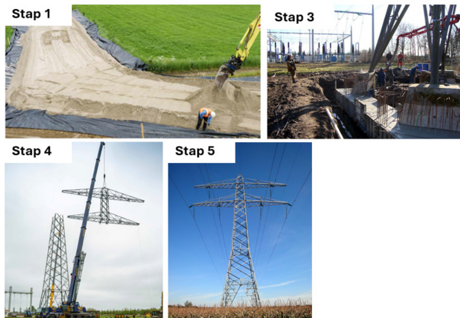
Afbeelding 5.2 Stappen werkzaamheden realisatie 380 kV-hoogspanningsmasten
