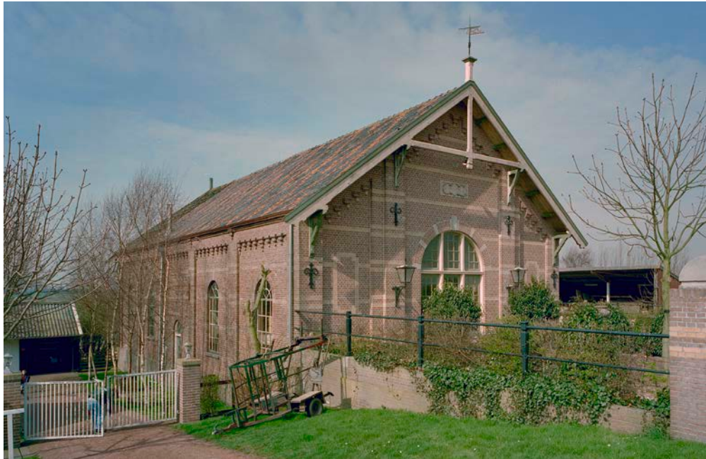
Afbeelding 4.11 Voormalig gemaal aan de Noorddijk (Bron: Beeldbank RCE)
