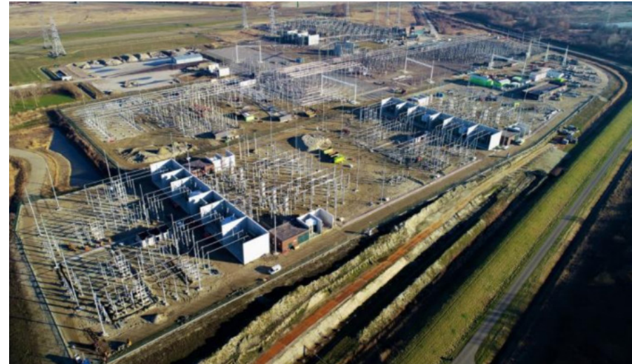
Afbeelding 5.4 380 kV-hoogspanningsstation Borssele tijdens de bouw
