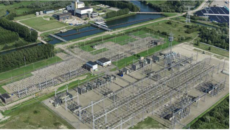
Afbeelding 1.5 380/150 kV-hoogspanningsstation in Diemen (bron: TenneT)
