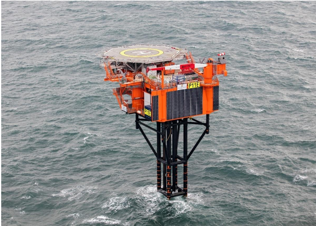
Figuur 5. P11-E-platform van ONE-Dyas behoort tot de opties voor hergebruik. Het CO 2 -injectieplatform Q16-B zal qua ontwerp overeenkomsten hebben met het P11-E-platform, zoals energieopwekking met hernieuwbare energiebronnen. Er nog geen definitieve beslissing genomen over het platformontwerp.
