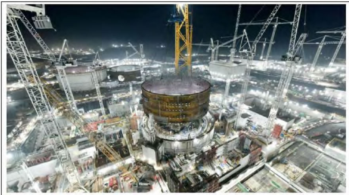
Detail van de bouwput van Hinkley Point C (foto Sky News)
