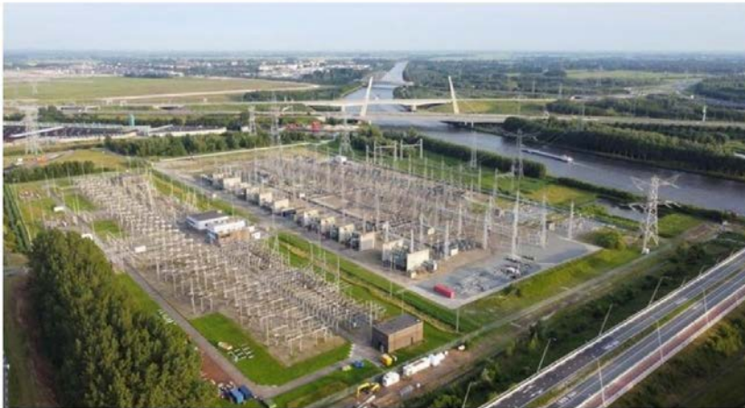
Figuur 2-3 | afbeelding van een 380/150kV-station (Diemen, ca. 18 ha)
