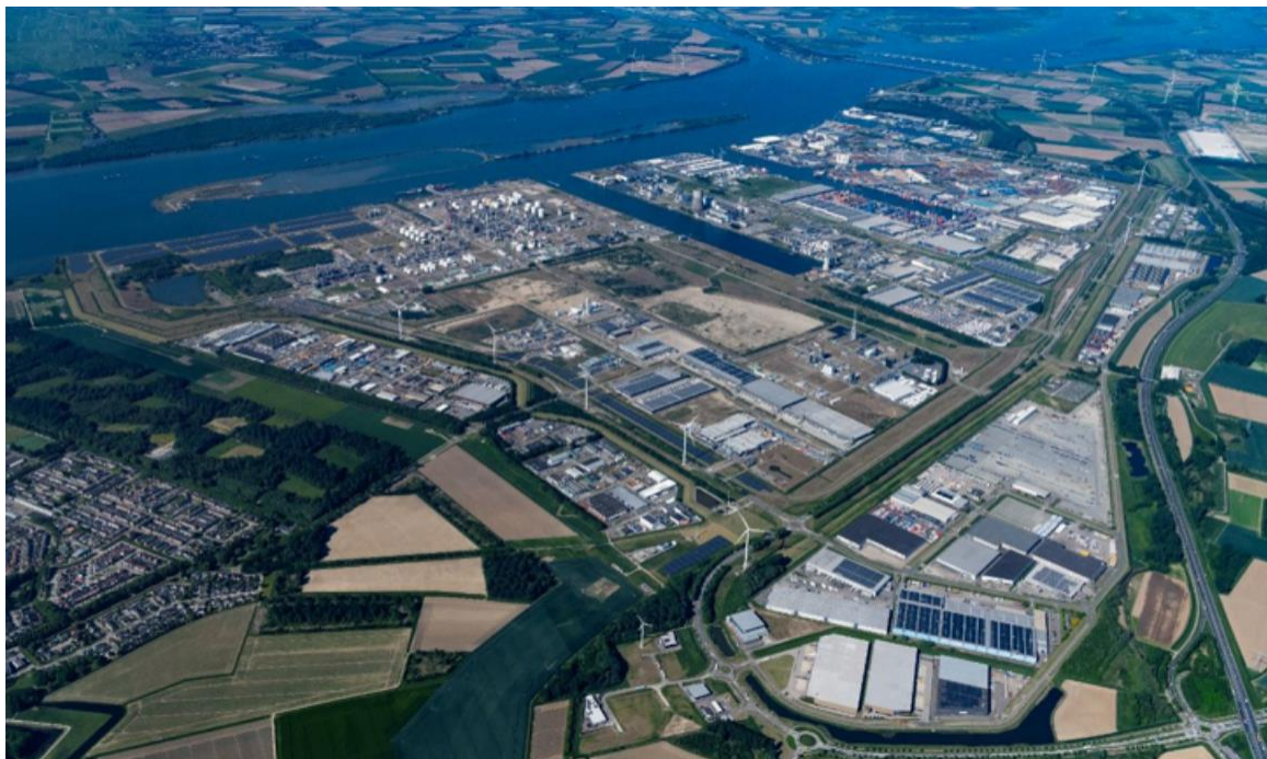
Figuur 2-18a: Luchtfoto haven- en industrieterrein Moerdijk, gezien vanuit het westen (Bron: TenneT).
