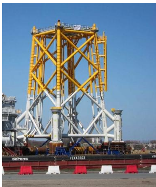
Figuur 5 Jacket met vier poten
