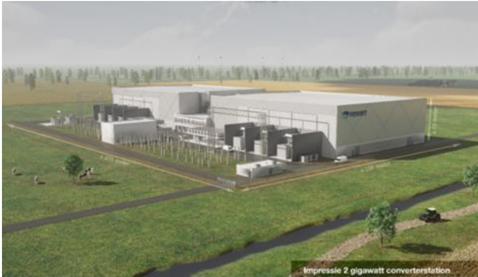
Figuur 5-2 Een impressie van een converterstation (uit Net op zee Nederwiek 3)
