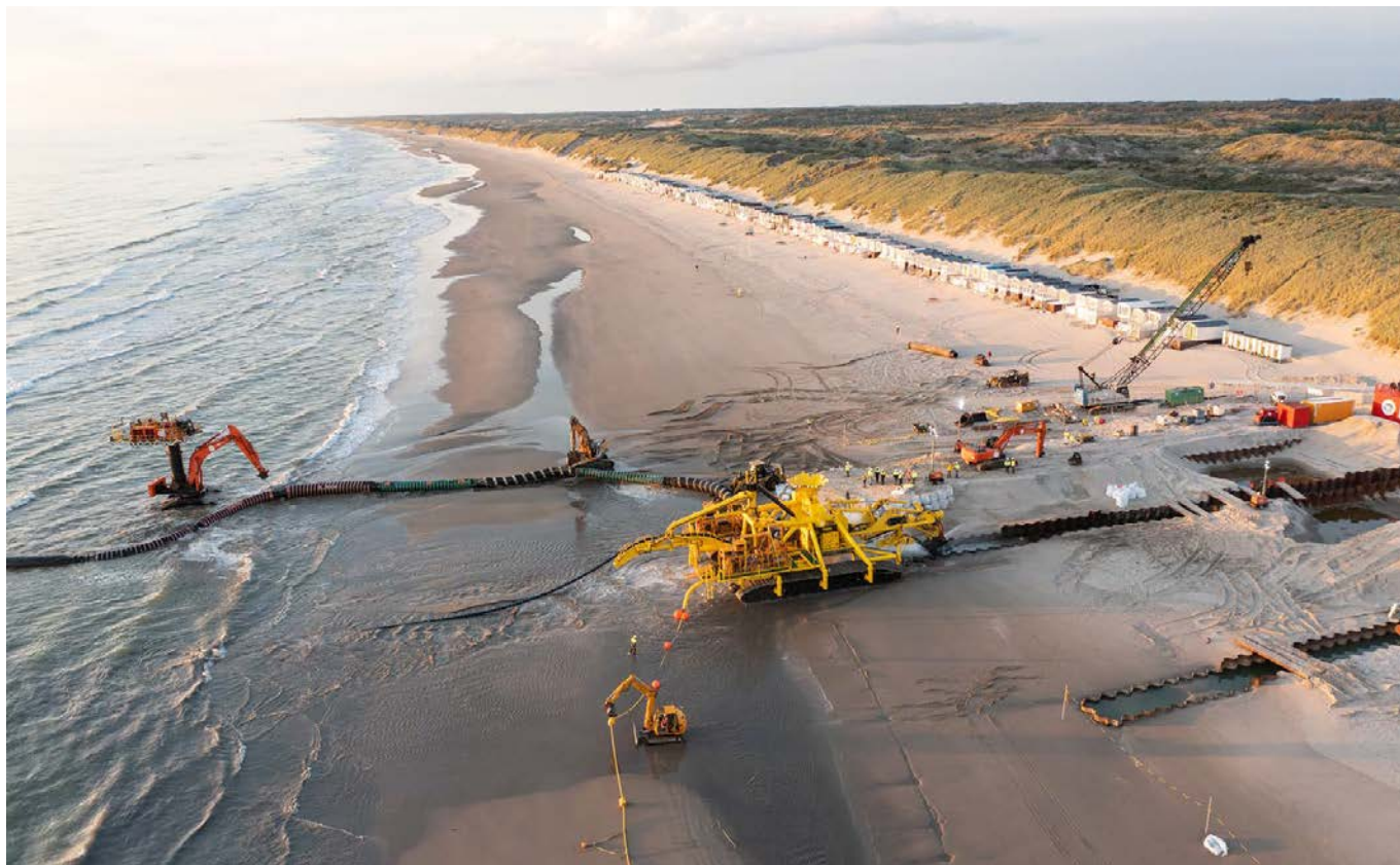
Aanleg kabels Wijk aan Zee.
