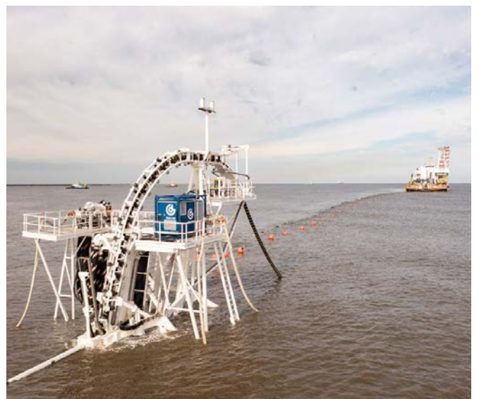
Figuur 2: Aanleggen van een 2 GW elektriciteitskabel op zee.
