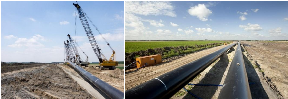
Figuur 2 foto's van een leidingen in open ontgraving
