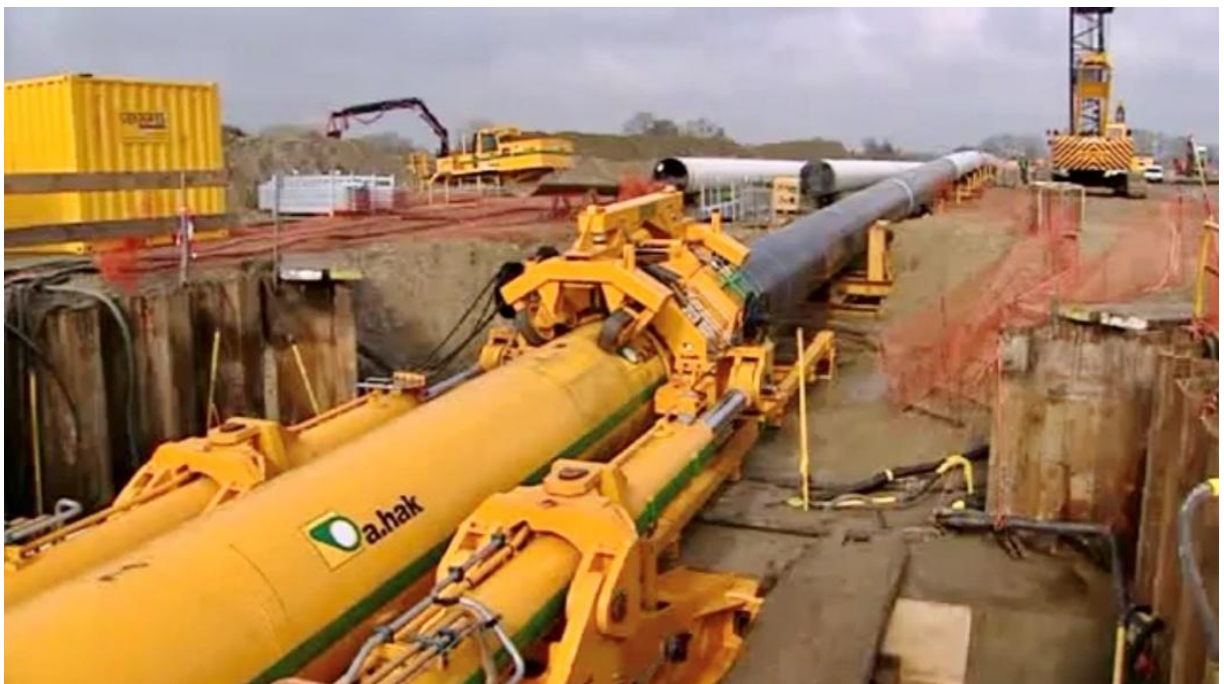
Figuur 5 Pijpleiding met de direct pipe techniek
