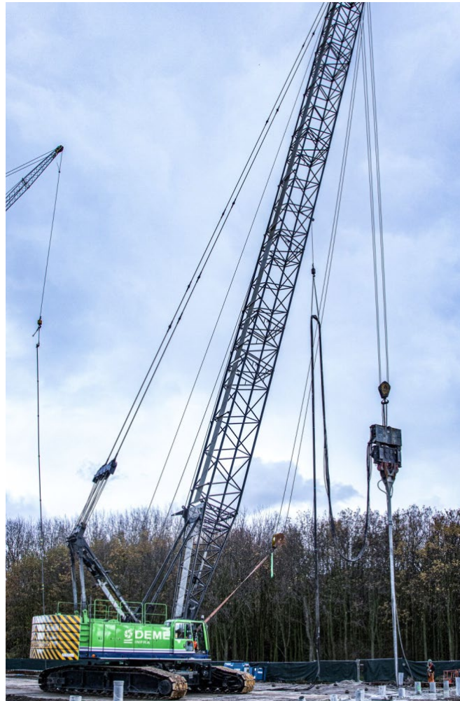
Figuur 3-9 Voorbeeld in te zetten heistelling
