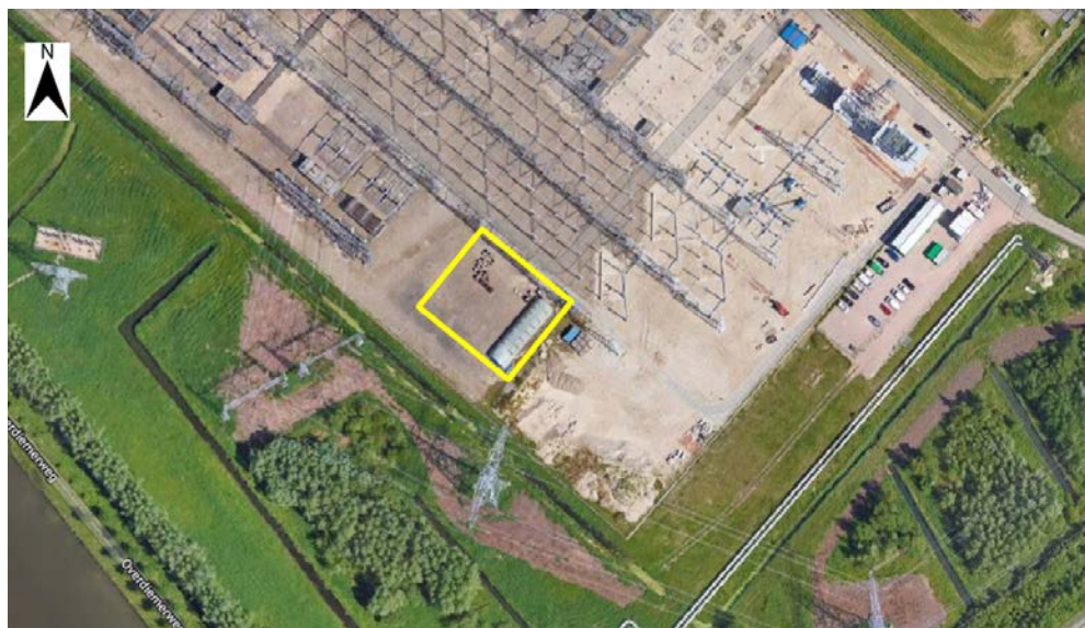
Figuur 5.7 Gereserveerde ruimte op station Diemen voor aansluiting van de nieuwe 380 kV-verbinding
