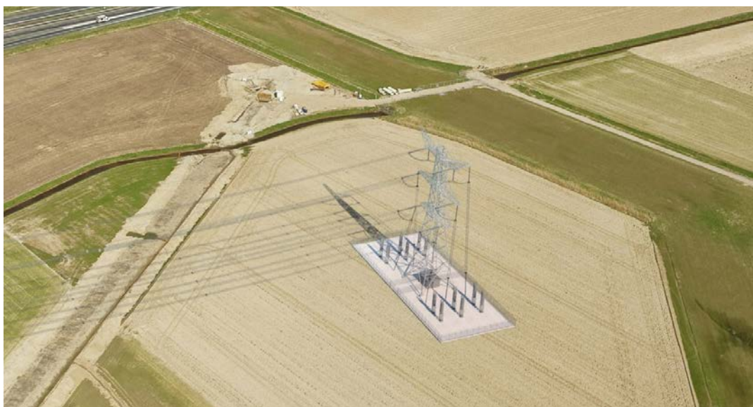
Figuur 5.9 Opstijgpunt 380 kV-verbinding (foto van de verbinding Rilland-Tilburg)
