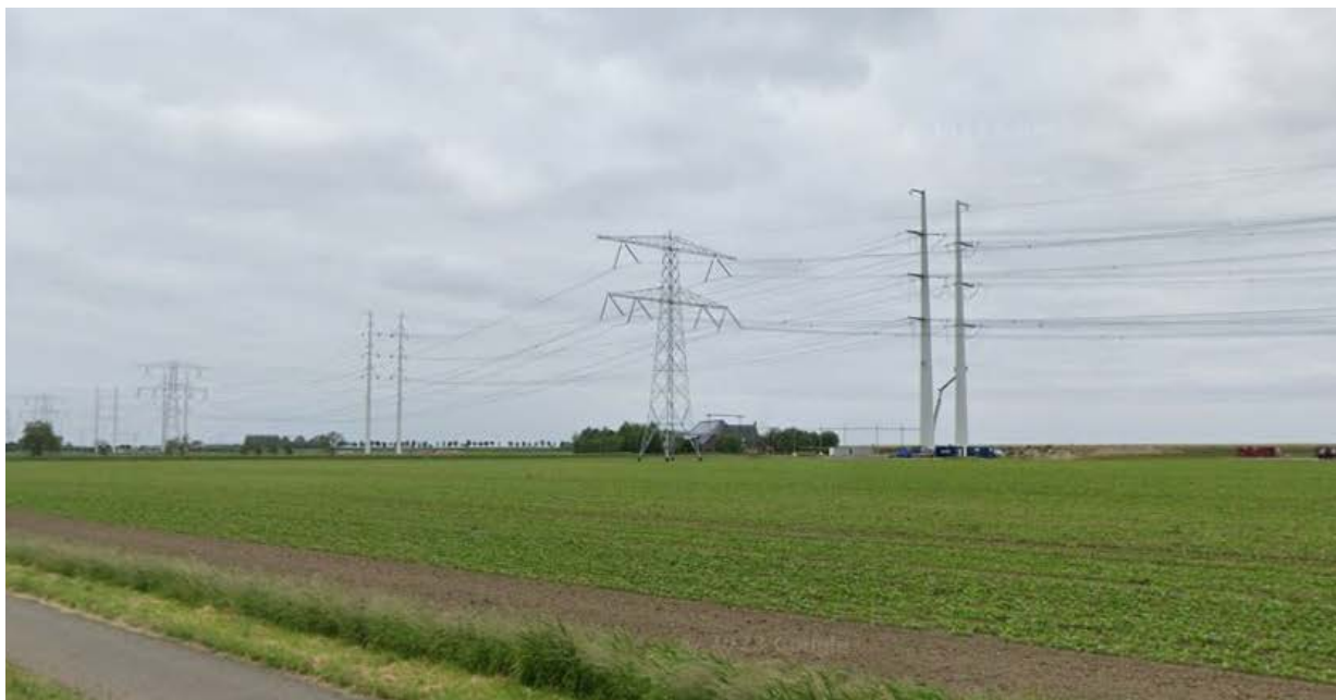
Figuur 5.2 Naast elkaar een 380 kV vakwerkmast ('Eiffeltoren') en een 380 kV wintrackmast (pilaren) (bron: Google Streetview, ter plaatse van A58/N289 nabij Rilland)
