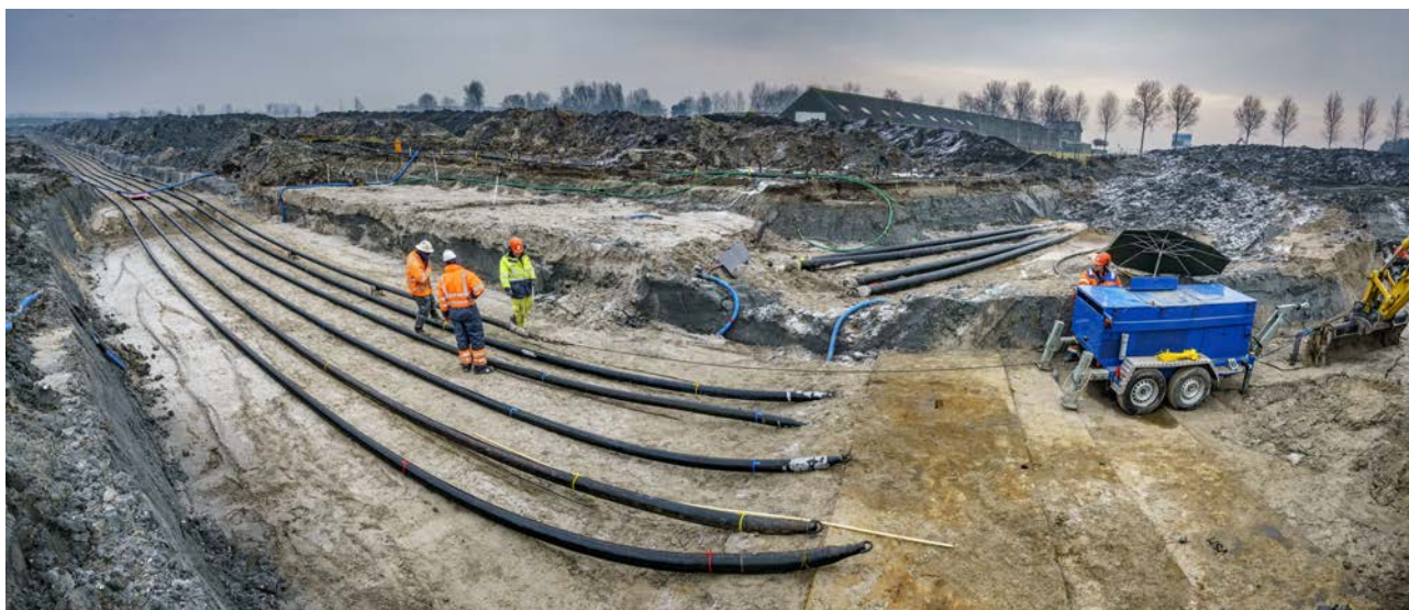
Figuur 5.10 Open ontgraving van 6 kabels (1 circuit)
