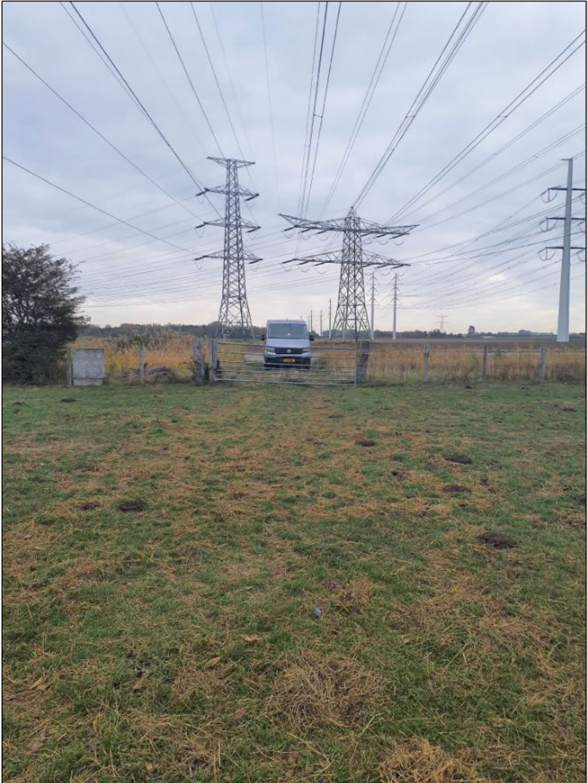
Foto 8: Toegang aan de Kaaiweg met afsluitbare poort
