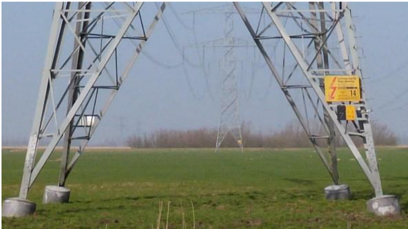
Figuur 10-4: Fundering van een vakwerkmast
