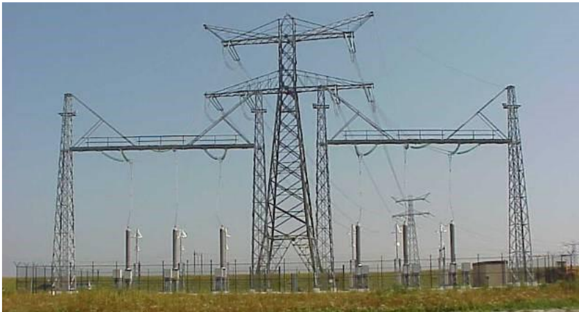
Figuur 10-7: Kabeleindsluiting (KES)
