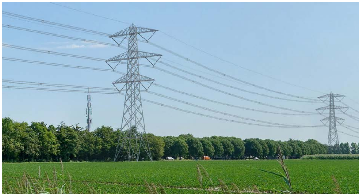
Afbeelding 4.1 Visualisatie van een Moldau mast in het landschap (bron: projectatlas Zuid-West 380kV-oost)
