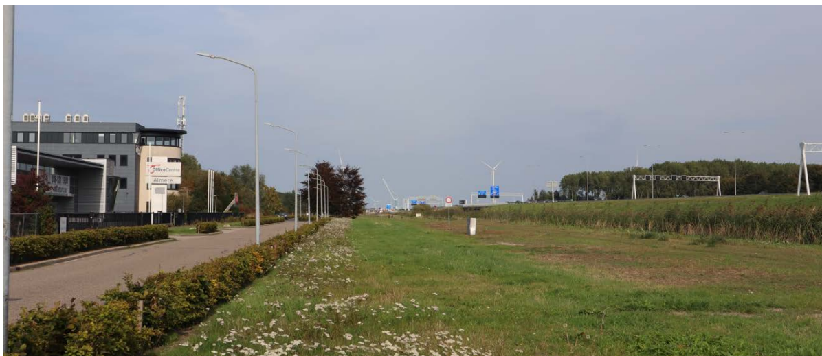
Foto 3 Onderzoeksalternatief Zuid-Paars-1 ligt parallel aan de A6 en volgt deze over een lange lengte
