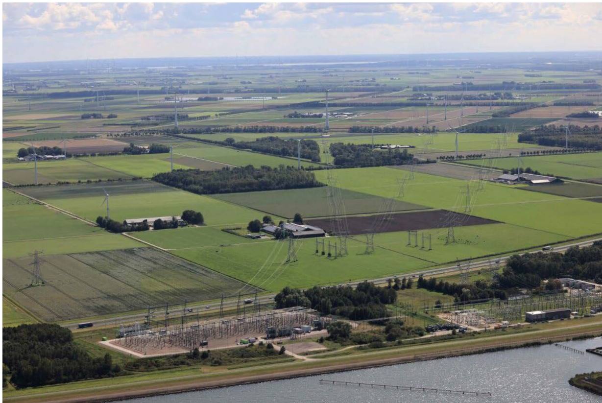
Figuur 1.3 Luchtfoto 380 kV-hoogspanningsstation Lelystad (links) en 150 kV-hoogspanningsstation Lelystad (rechts)
