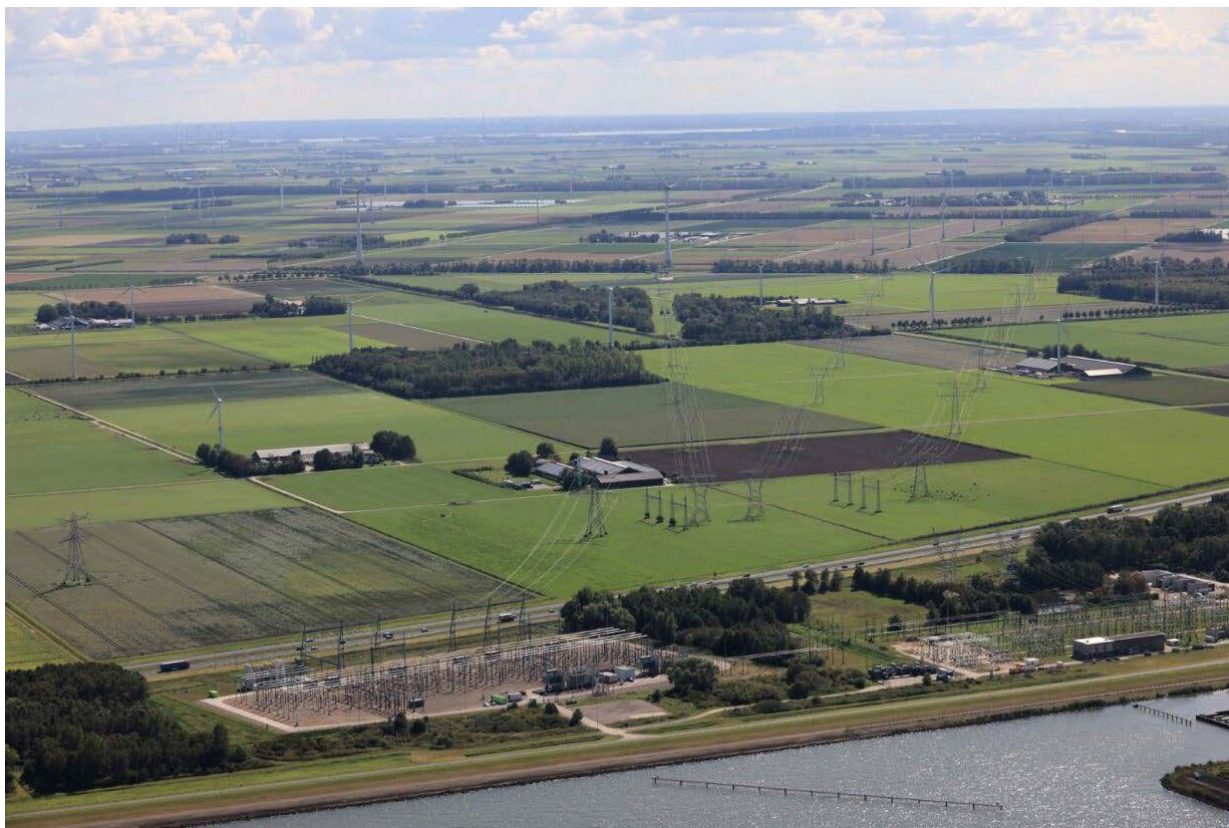
Figuur 2.5 Luchtfoto 380 kV-hoogspanningsstation Lelystad (links) en 150 kV-hoogspanningsstation Lelystad (rechts)
