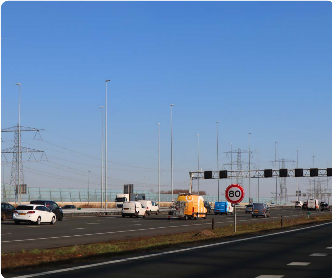
Het bestaande 380 kV hoogspanningstracé tussen Diemen en Ens langs de A1
