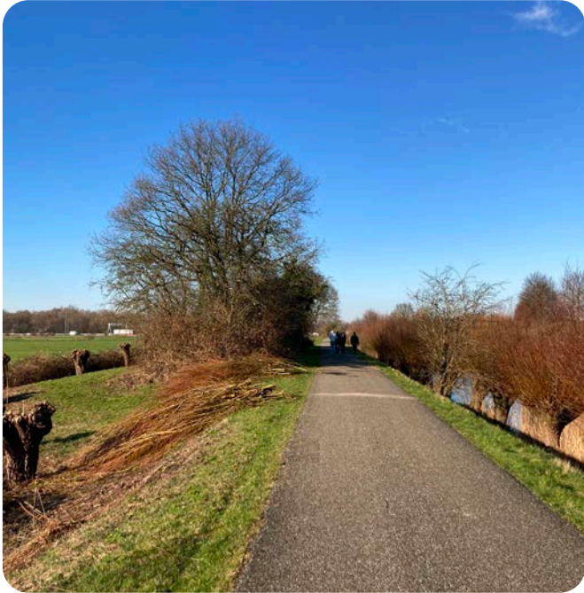
Hoofdverdedigingslijn van de oorspronkelijke Nieuwe Hollandse Waterlinie nabij fort Ronduit
