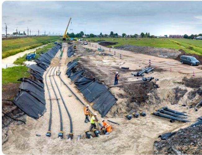
Foto van de aanleg van ondergrondse hoogspanningslijnen: open ontgraving (Bron: TenneT)
