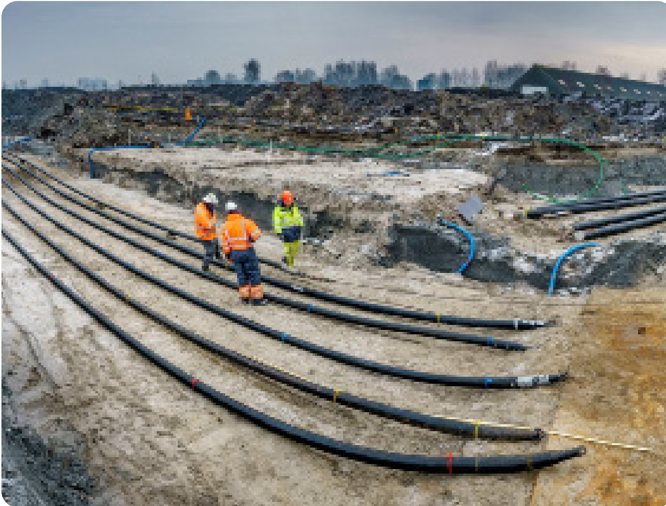
Referentiebeeld van het ondergronds aanleggen van een hoogspanningslijn: E-Power-Pipe Bron: https://www.tennet.eu/nl/over-tennet/innovatie-en-partnerships/horizontaal-boren
