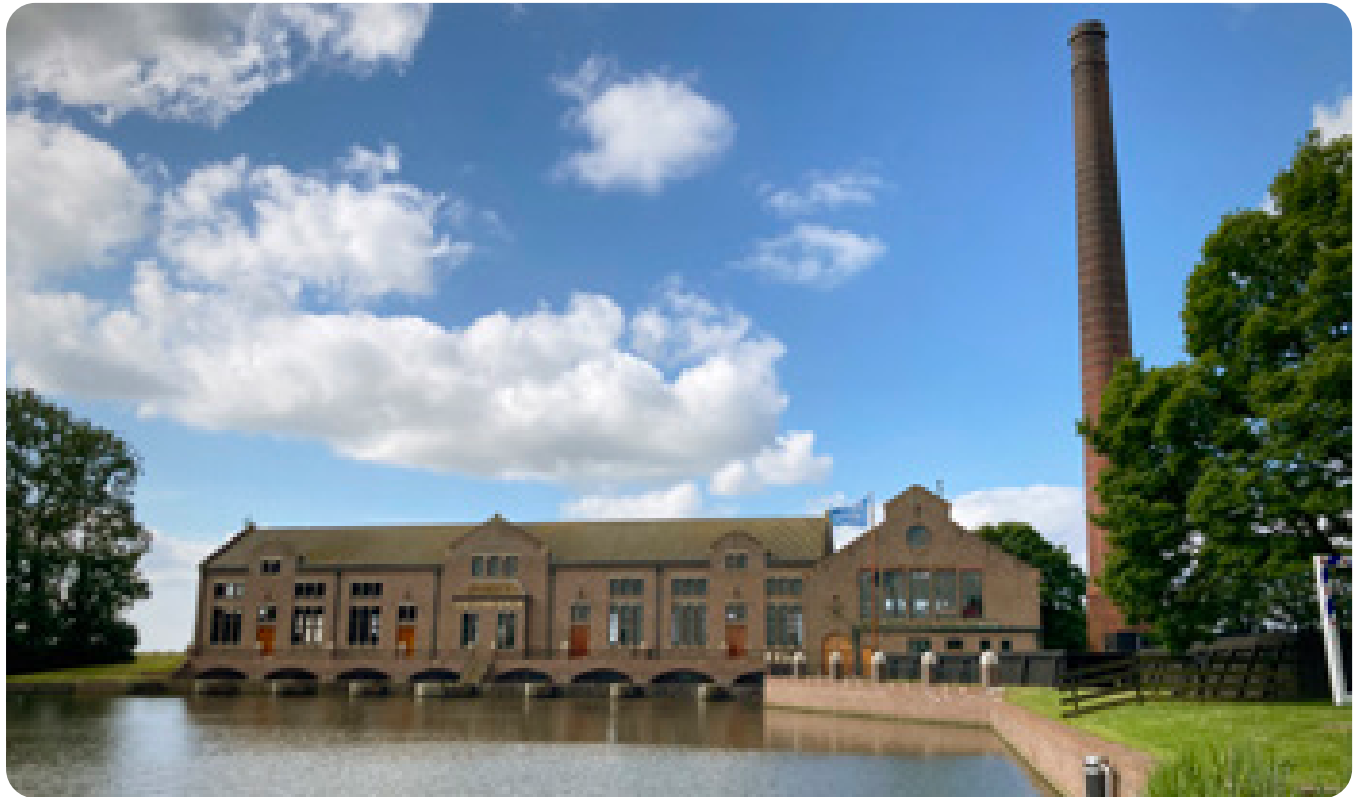
Vooranzicht van het Ir. D.F. Woudagemaal dat nog steeds in functie is. Opvallend is de 60 meter hoge schoorsteen
