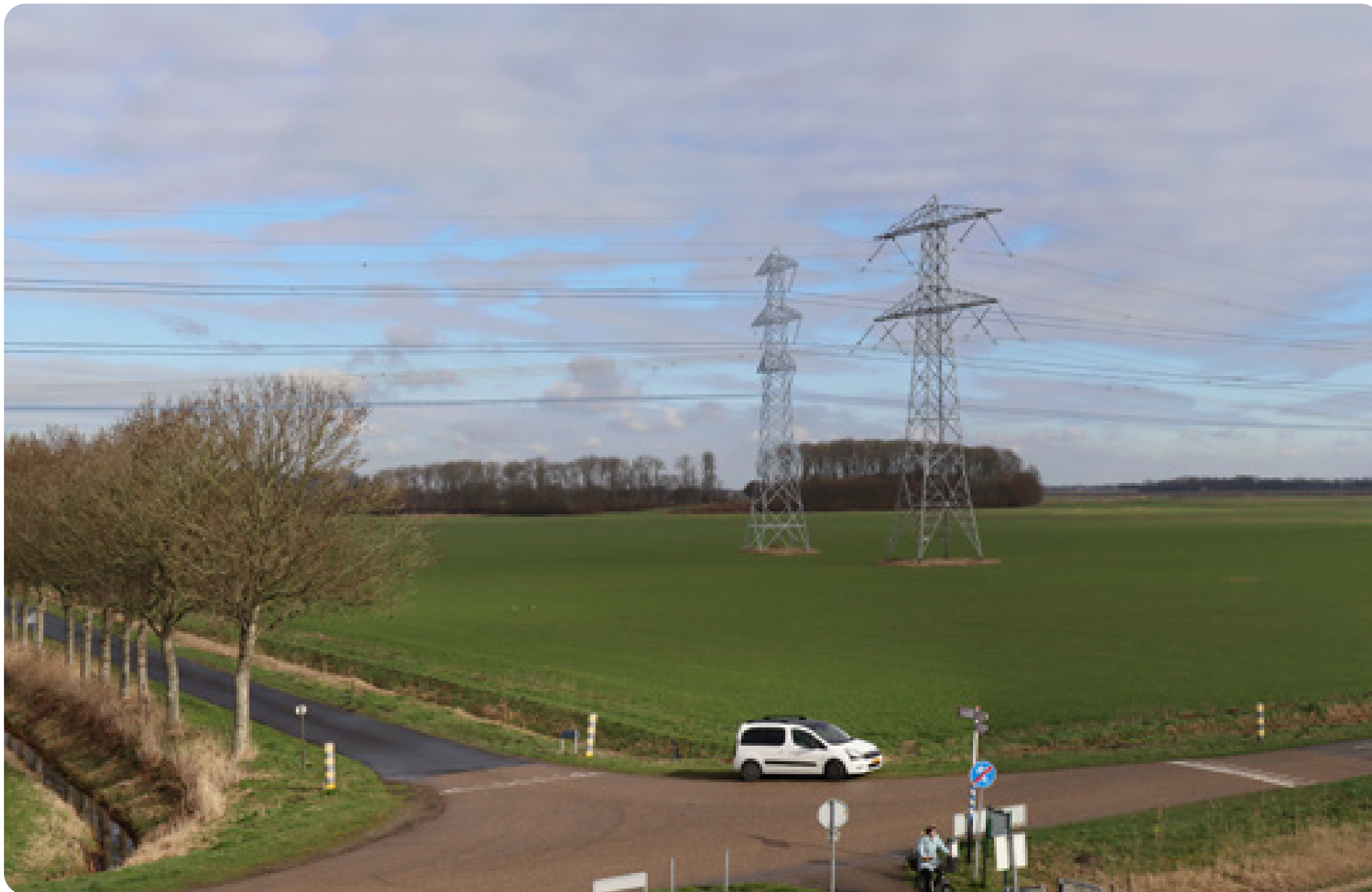
Inzoom op de fotomontage van de vorige pagina. De opstelling van de hoogspanningslijn overstijgt de schaal van het eiland ensemble waardoor de zichtbaarheid van het voormalige eiland in de polder ‘verkleint’. De hoogspanningslijn is concurrerend met de opgaande elementen van het eiland.
