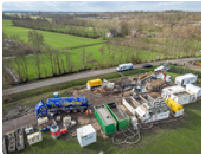
Foto van de aanleg van ondergrondse hoogspanningslijnen: gestuurde boring (Bron: TenneT)
