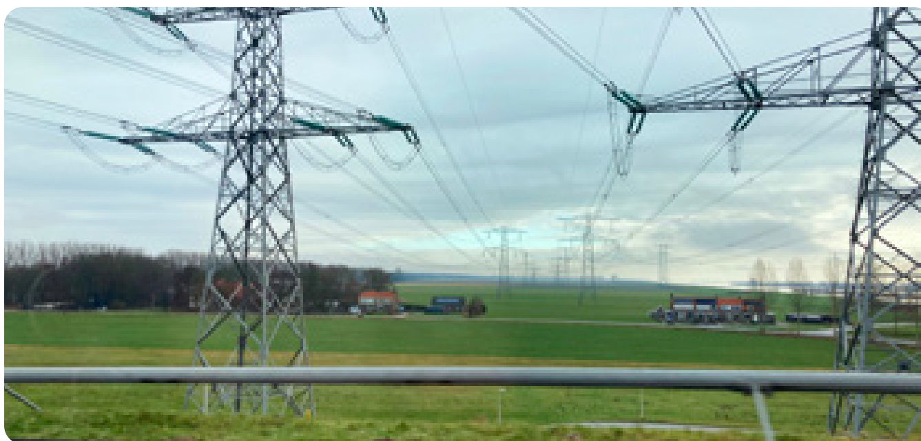
Op plekken nabij hoogspanningsstations zoals bij hoogspanningsstation Ens, neemt het aantal hoogspanningsmasten toe
