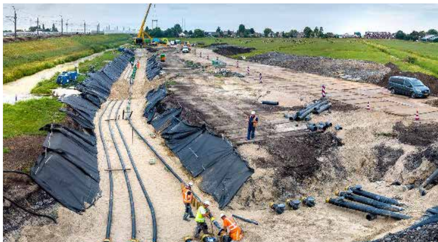
Afbeelding 21. Referentiebeeld van een open ontgraving (TenneT)
