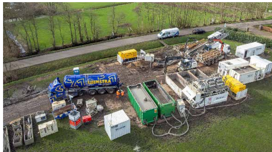
Afbeelding 22. Referentiebeeld van een gestuurde boring (TenneT)
