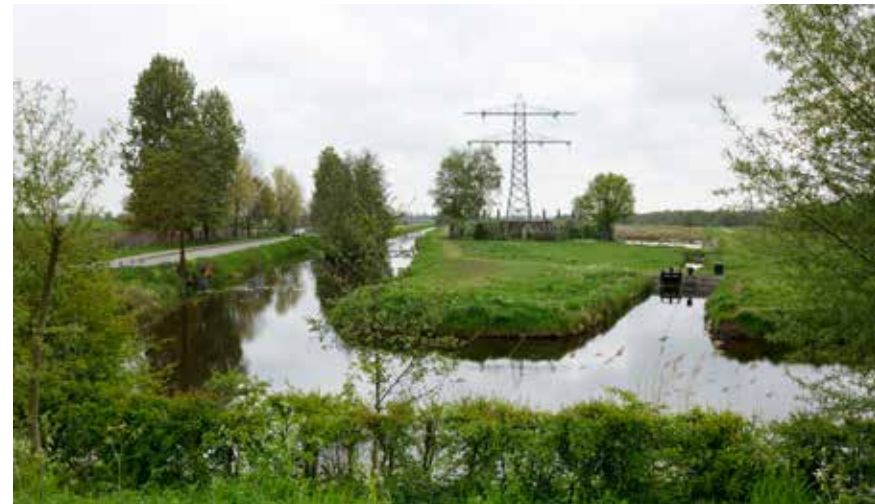
Afbeelding 47. Hoogspanningsopstijppunt bij Fort de Gagel, Hollandse Waterlinies Bron: Beeldbank Rijksdienst voor het Cultureel Erfgoed. Doc. Nr. 546.156
