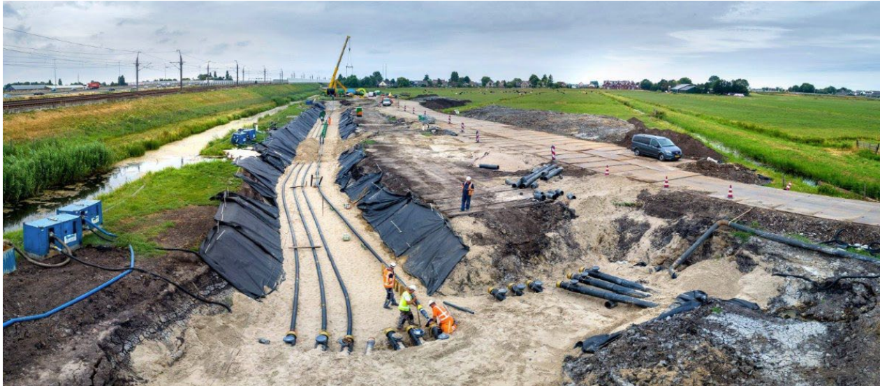
Figuur 2.3: Voorbeeld werkzaamheden open ontgraving.
