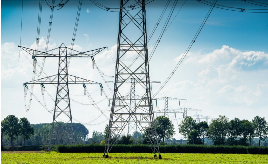
Figuur 5.1: Hoogspanningsverbinding bovengronds (type Donaumasten)
