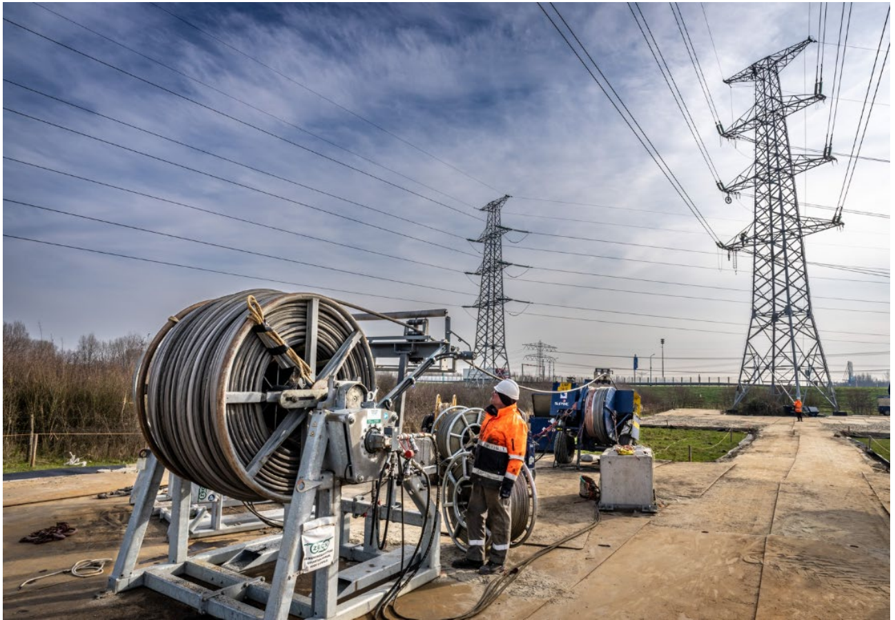
Figuur 5.3: Het intrekken van de geleiders
