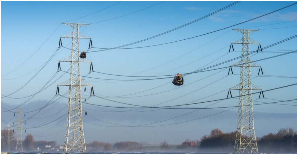
Figuur 5.6: Aanbrengen van bundelafstandhouders met invaarwagens
