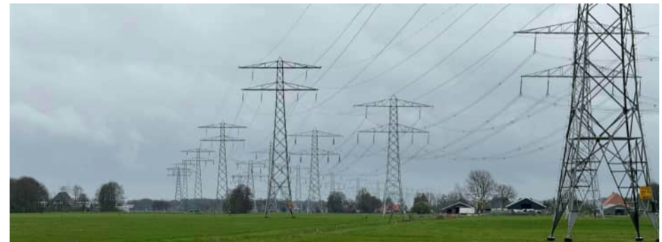
Foto B: Voorbeeld van visuele complexiteit door bundeling van 220 kV en 110 kV-hoogspanningsverbindingen met masttype Donau (bij Vogelzangweg, Oudehaske)
