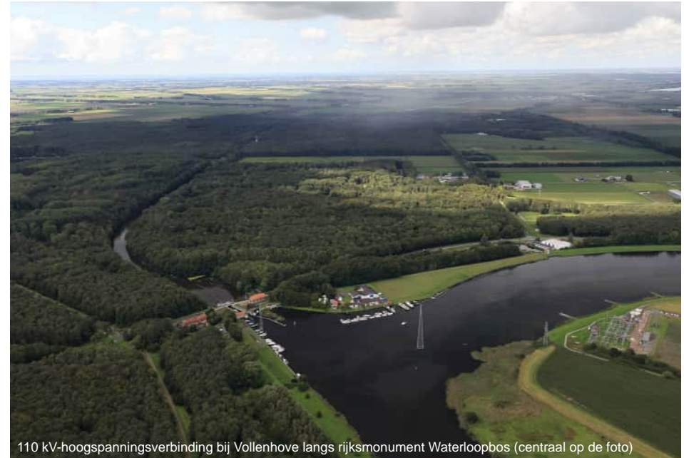
110 kV-hoogspanningsverbinding bij Vollenhove langs rijksmonument Waterloopbos (centraal op de foto)
