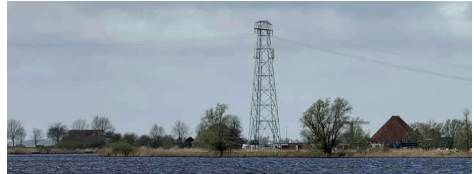
Foto A: Voorbeeld van een storend contrast door hoge 110 kV hamerkopmast naast boerderij (langs het Tjeukemeer)
