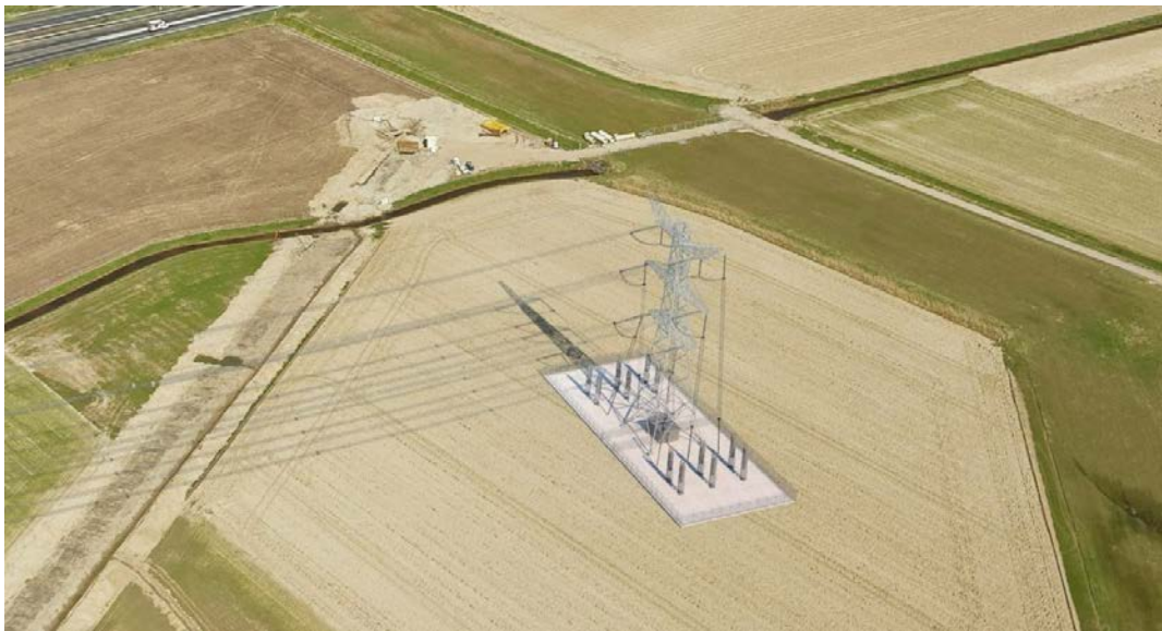
Figuur 7.3: Opstijgpunt 380kV-verbinding (foto van de verbinding Rilland-Tilburg).
