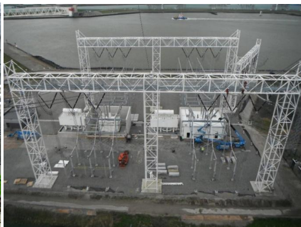
Figuur 3.8: Twee seriespoelen (één per circuit)
