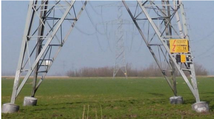
Figuur 7.4: Fundering van een vakwerkmast
