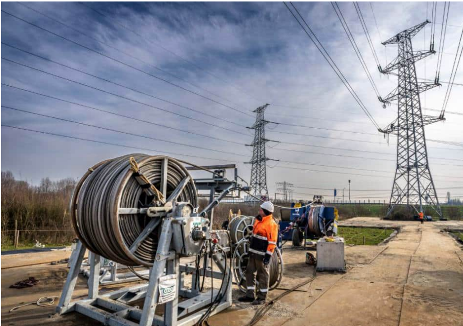
Figuur 3-10 | Intrekken geleiders in hoogspanningsmast
