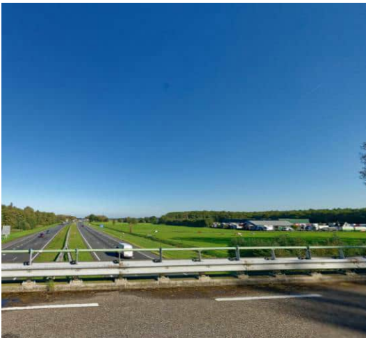
Figuur 3-3 | Visualisatie verandering toekomstige situatie (2x 380 kV, rechts) ten opzichte van huidige situatie (geen hoogspanningsverbinding, enkel bovenregionale infrastructuur, links)
