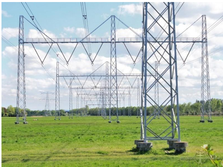
Figuur 8.9 Foto van portalen. Bron: hoogspanningsnet.com
