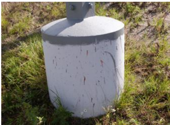
Figuur 1.16 Een voorbeeld van de verharding boven maaiveld van een mastvoet, bij een met beton gevulde stalen buispaal
