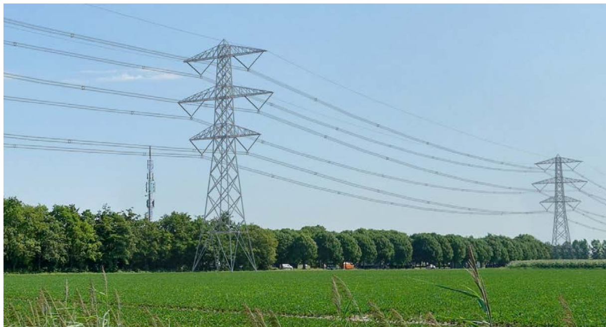
Figuur 1.15 Visualisatie van een Moldau mast in het landschap (bron: projectatlas Zuid-West 380kV-oost)
