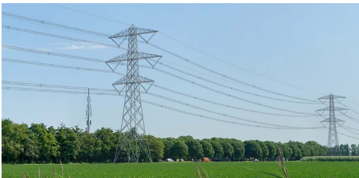
Figuur 1.15 Visualisatie van een Moldau mast in het landschap (bron: projectatlas Zuid-West 380kV-oost)
