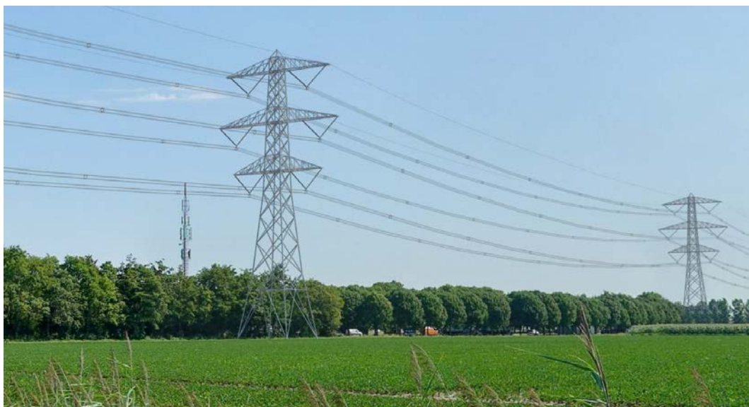
Figuur 1.15 Visualisatie van een Moldau mast in het landschap (bron: projectatlas Zuid-West 380kV-oost)
