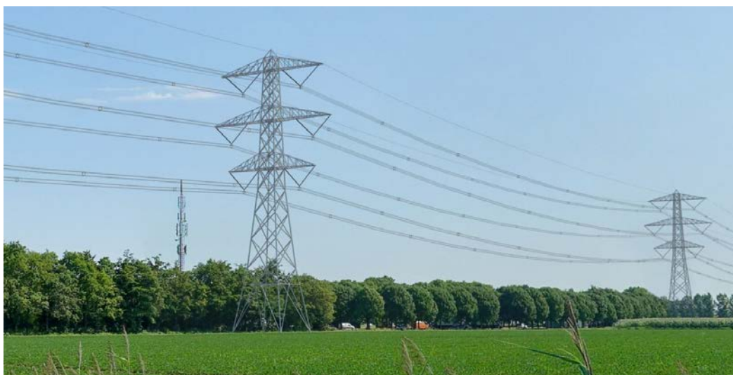
Figuur 1.15 Visualisatie van een Moldau mast in het landschap (bron: projectatlas Zuid-West 380kV-oost)
