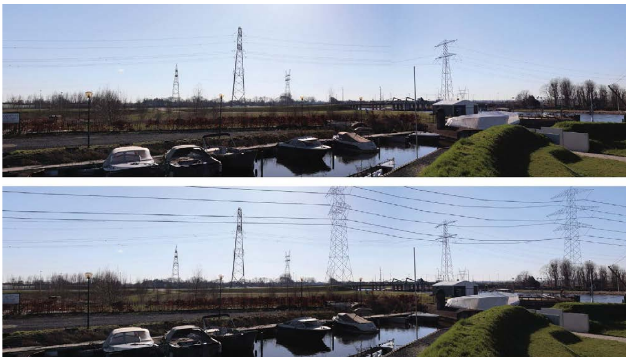
Figuur 5.20 Huidige situatie (boven) en fotomontage van de nieuwe situatie (onder) van deeltracé PA1 bij Muiden
