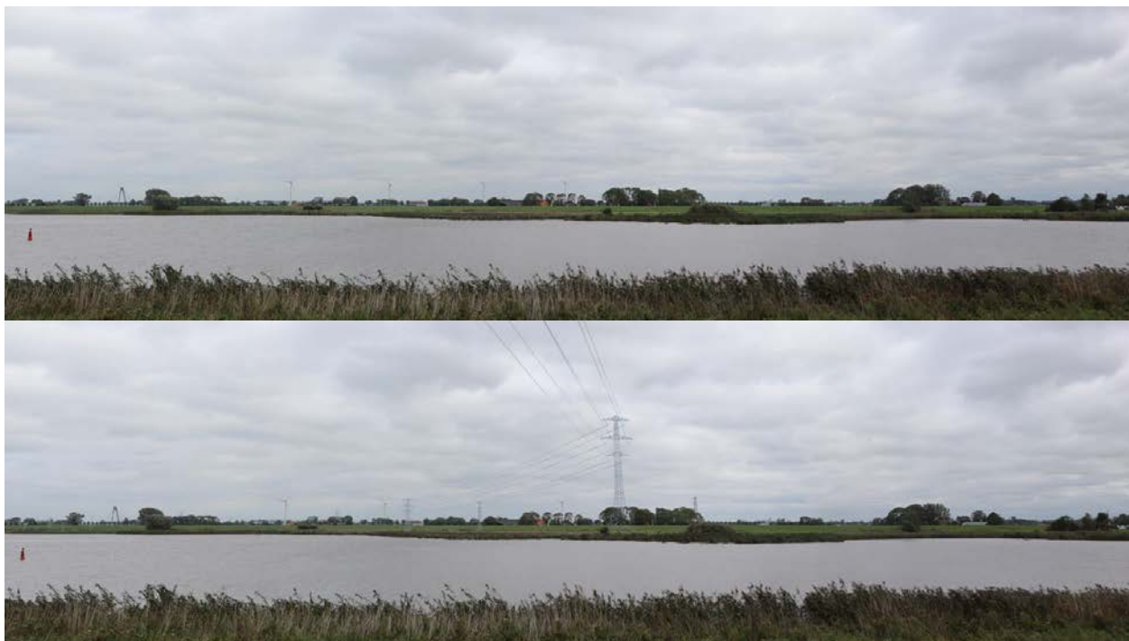
Figuur 6.25 Huidige situatie (boven) en fotomontage van de nieuwe situatie (onder) met deeltracé OR17a, bij de oversteek van het Vossemeer
