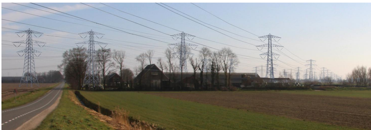
Figuur 6.32 Fotomontage GS2 van cumulatie van vier 380kv hoogspanningslijnen vanaf de Drietoerensweg ten noordwesten van Ens
