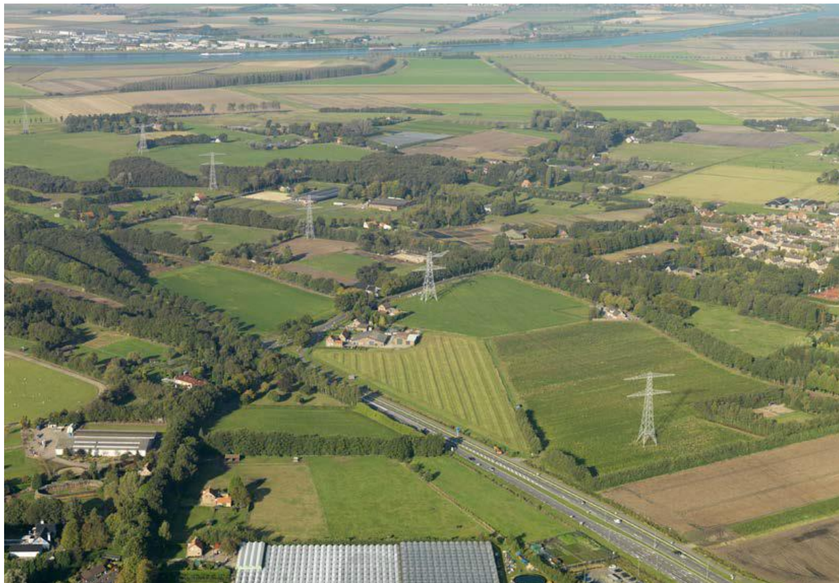
Figuur 3.1 Een 380 kV verbinding in een kleinschalig Brabants landschap: het landschap met historische, karakteristieke verkaveling en beplanting lopen 'ongestoord' onder de verbinding door. (bron: Landschap en hoogspanningsnet, 2017)
