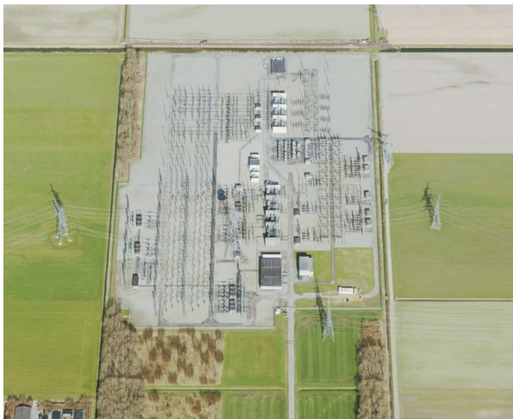
Figuur 2.5 Hoogspanningsstation Ens
