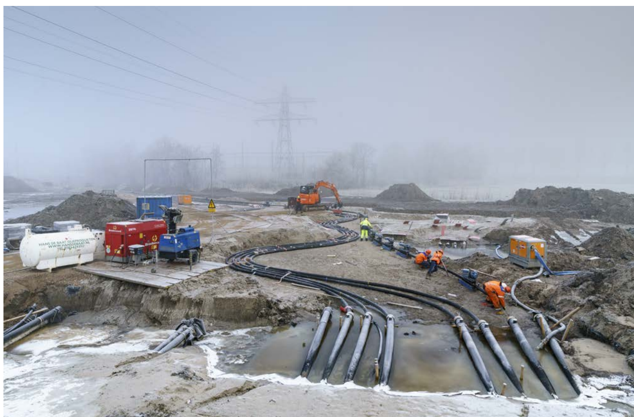
Figuur 2.7 Gestuurde boring 380 kV kabels
