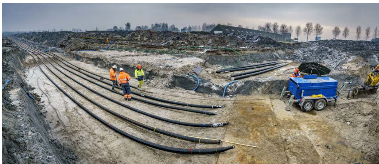
Figuur 2.6 Voorbeeld van hoe een open ontgraving in zijn werk gaat
