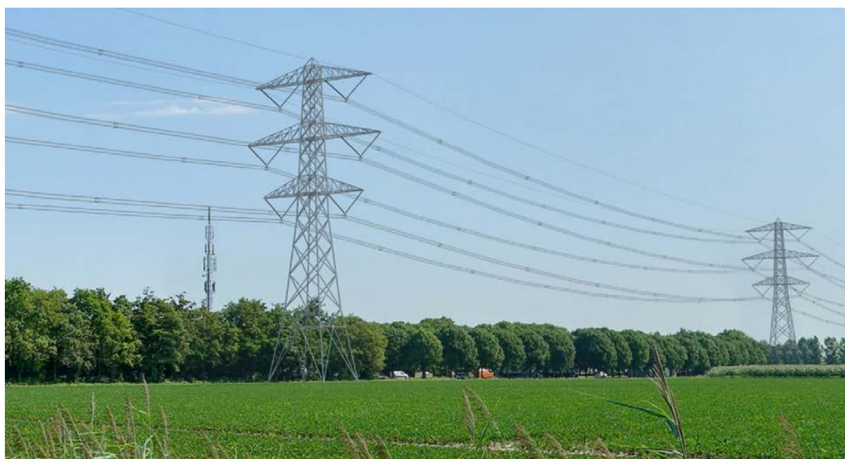
Figuur 2.3 Visualisatie van een Moldau mast in het landschap (bron: projectatlas Zuid-West 380 kV-oost)
