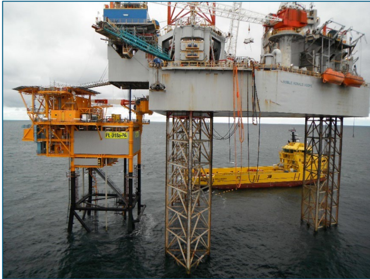
Figuur 2-1: Een boorplatform (op de afbeelding: bij het D18a-A platform).
