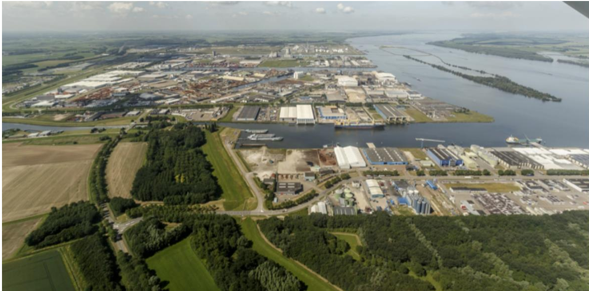
Figuur 2-18b: Luchtfoto haven- en industrieterrein Moerdijk, gezien vanuit het oosten (Bron: TenneT).
