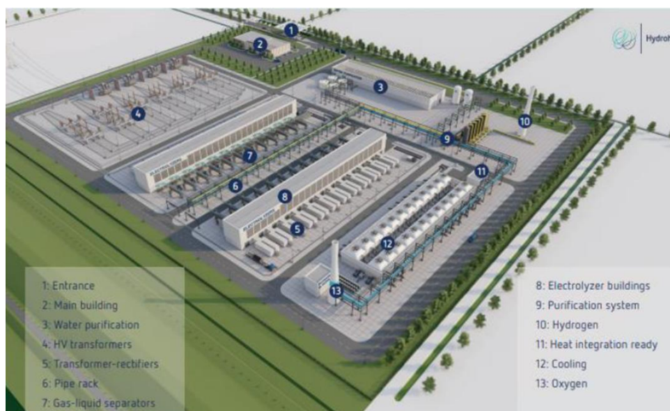
Figuur 2-3 Visualisatie 1 GW elektrolyser
